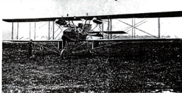
BM-5 varianta bombardier; se observă lănsatoarele sub aripă
