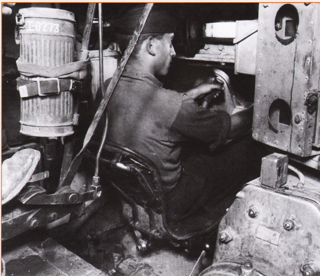
Внутренний вид танка Panzer III. Водитель сидит на своем месте. Справа от него коробка передач. Слева на педали пулемета видна нога артиллериста.
