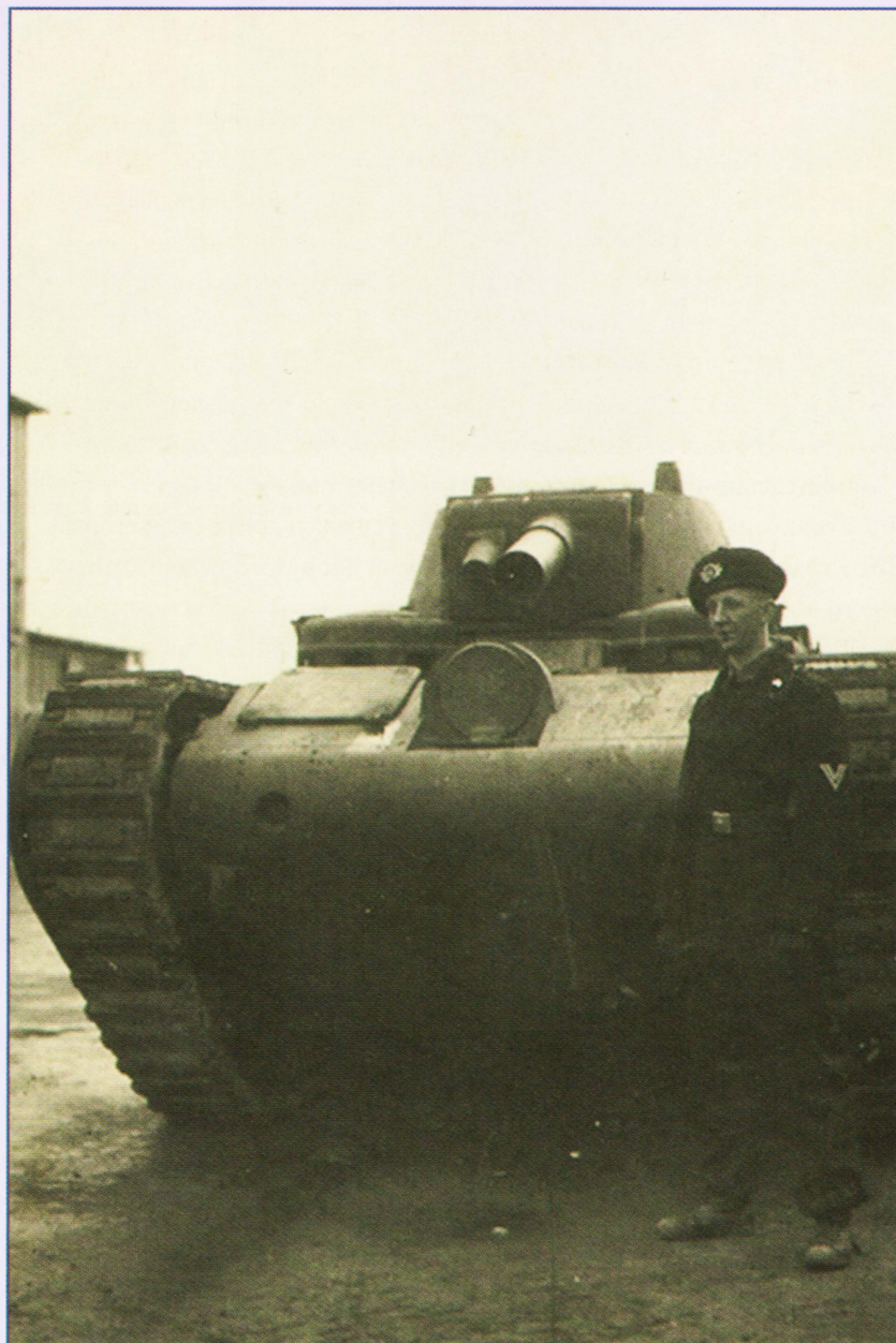
Опытная копия Daimler-Benz. Коаксиальный пулемет калибра 7,92 мм установлен рядом с пушкой. На танкисте черная форма танковых частей.
