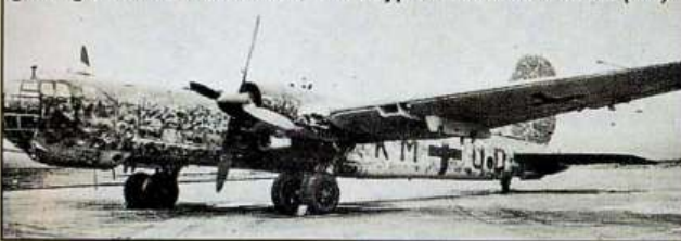
Eine He 177A-5/R-2 des KG 100 in Toulouse-Blagnac, 1944. Sie trägt noch die Werkskennung (KM+UD) und die Bombenanhänge für Fernlenkbomben vom Typ Hs 293 und Fritz X. (DR)
