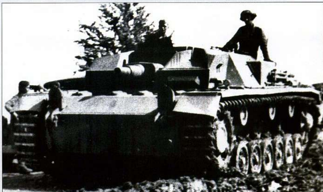
Ci-contre. Cette vue d'un Ausf. B montre une des faiblesses du StuG, l'absence d'armement secondaire. Parfois, une MG 34 sur bipied est montée sur la superstructure et servie par un fantassin ou un membre d'équipage. (DR).
