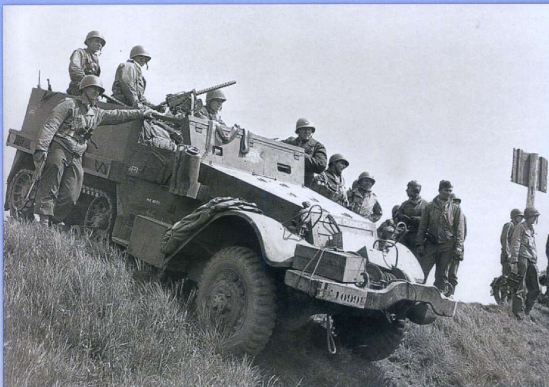
Ci-contre. Le half-track 410 991 négocie lentement la pente sur le berge nord de l'Elz et descend vers le gué. (ECPAD)
