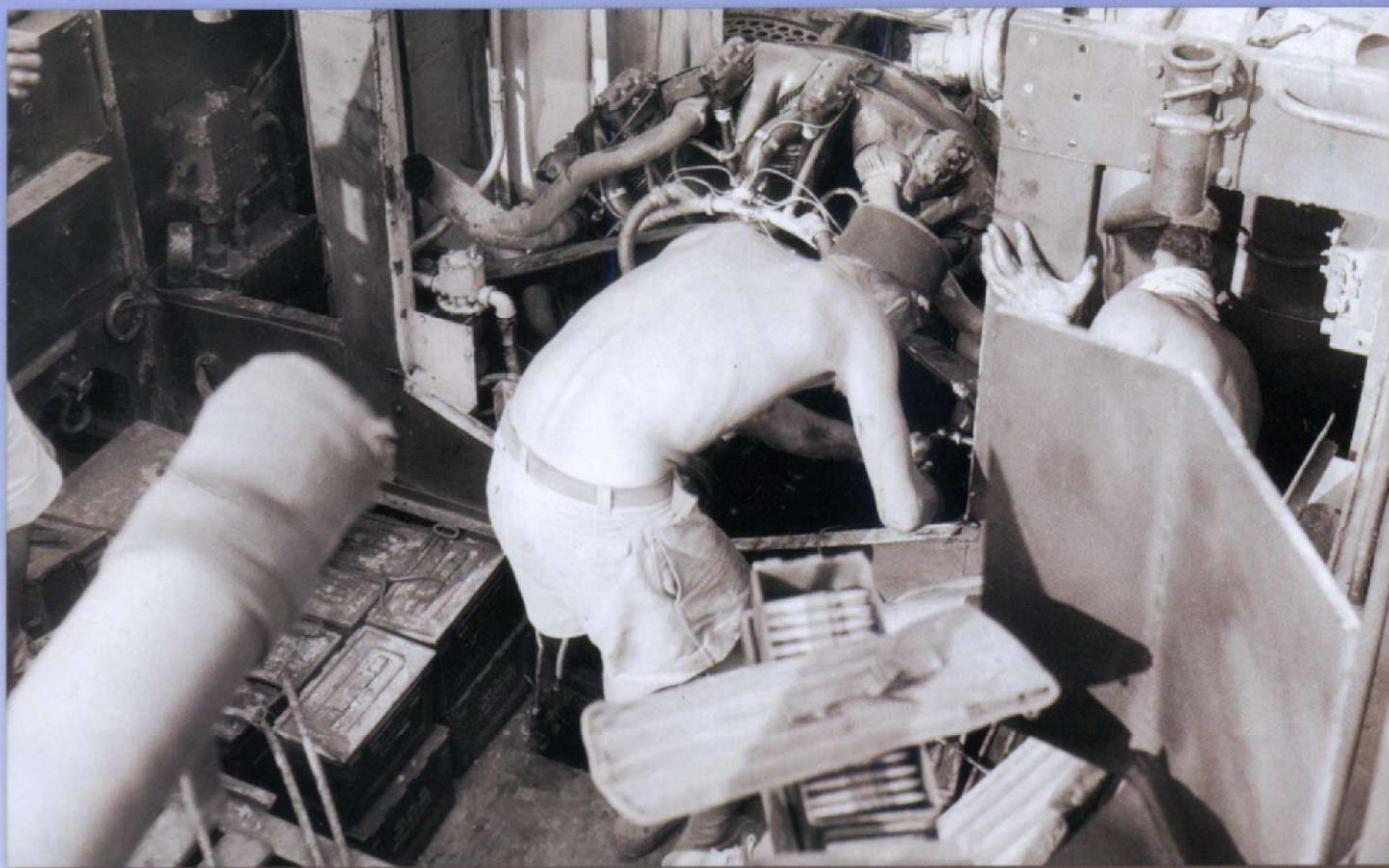
Ci-dessus. Le moteur de l'Alligator est un moteur d'avion en étoile Pratt & Whitney. Il est relativement facile d'accès.
