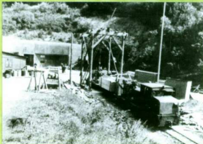
Ci-contre. Sur l'ouvrage du Hochwald en 1944, l'occupant allemand emploie la voie étroite pour transporter à l'intérieur des machines-outils. (Coll. J.-B. Wahl et P. Jost)
