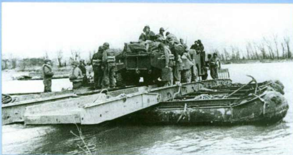
Ci-contre. 1 er avril 1945. Les éléments du groupement de Toulouse-Lautrec franchissent le Rhin sur les portières Treadway. L'AM M20 Passy (mie 415 349) du chef d'escadrons commandant en second, a pris place sur le chemin de roulement derrière un Scout car du 3 e Spahis marocains. (DR)
