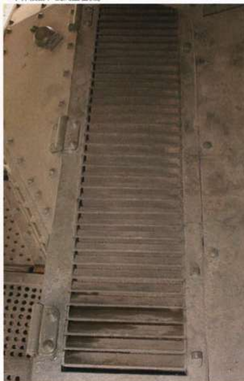
▼車体後部、機関室左側。
