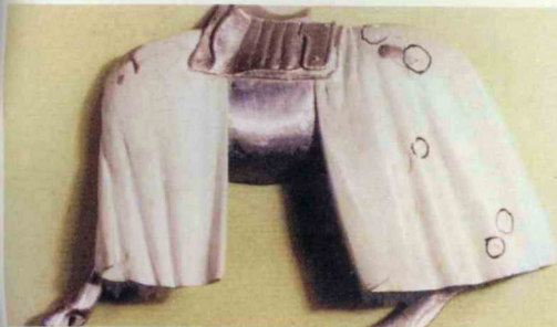
Работа продолжается. Кругами отмечены дефекты поверхности миллипута, которые нуждаются в дополнительном шпательном.
