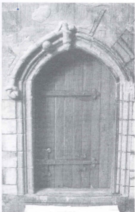
Собранная дверь установлена в дверной проем, облицовка дверного проема еще не завершена.
