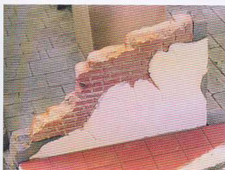
Процесс окраски внутренней поверхности ничем не отличается от процесса окраски фасада.
