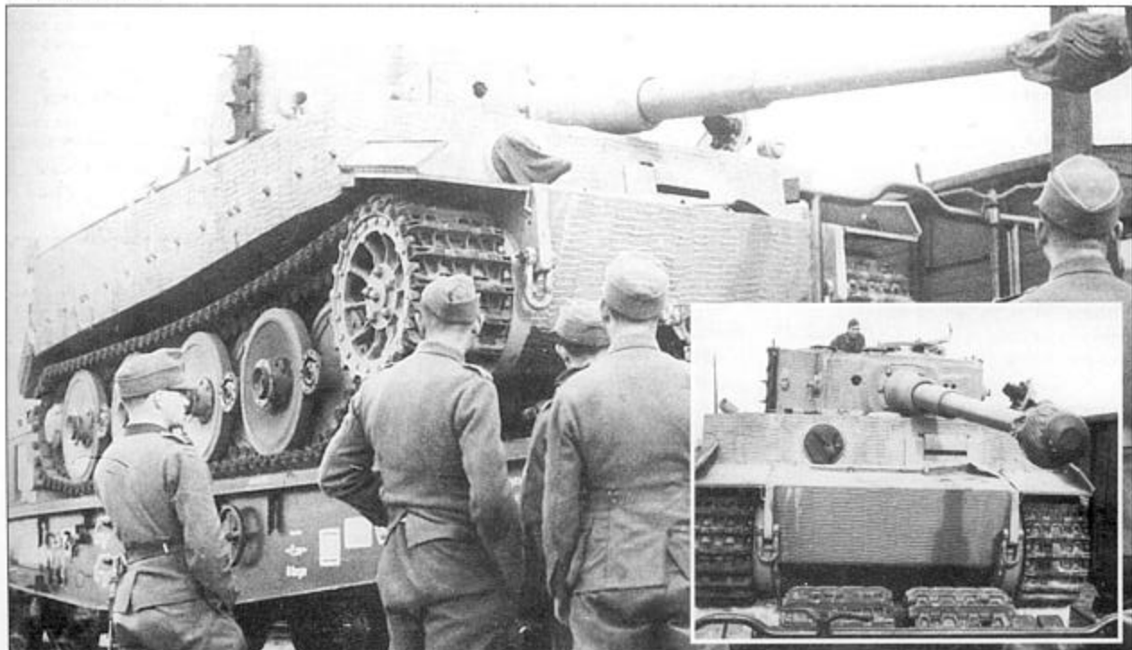
Два снимка довольно редкой разновидности «Тигра»: командирская башенка – литая, одна фара Бойш установлена не по центру, а в левом углу надстройки корпуса. Лопата на лобовом бронелисте корпуса уложена задом наперед. Датировка выпуска танка – август – сентябрь 1943 г. Судя по наклону ствола можно говорить о неисправности фиксатора казенной части орудия в походном положении.
