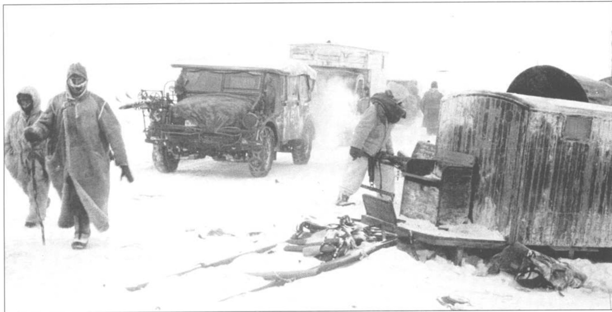
Колонна на марше. Битва за Сталинград проиграна вермахтом. На снимке – Хорьх Kfz. 70 позднего выпуска с внутренним расположением запасных колес. По правому борту машины закреплены лыжи. Колеса для лучшей проходимости по снегу обмотаны цепями. Капот двигателя закрыт теплым чехлом.
