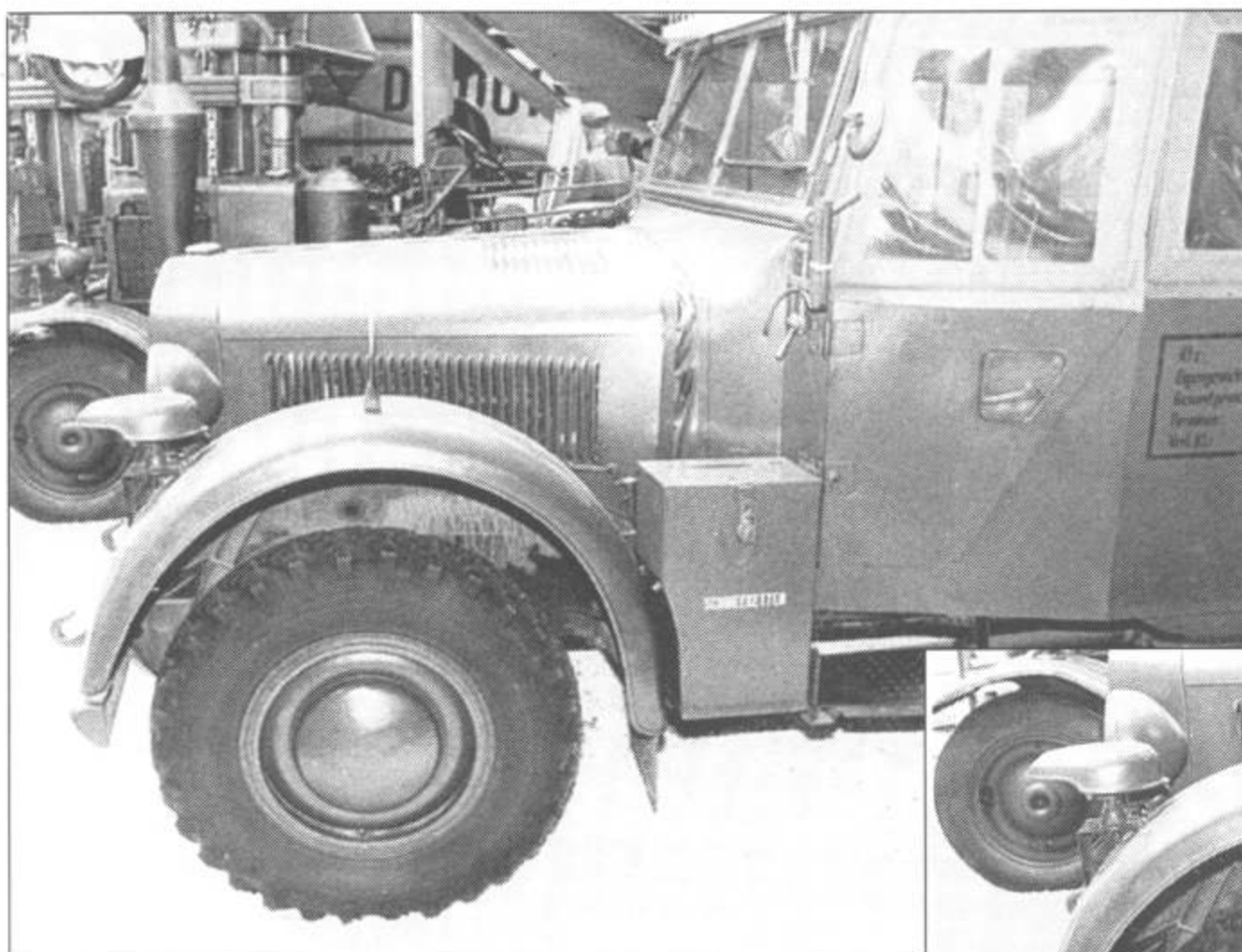
Крупный план передней части левого крыла – обычная фара и фара Нотек. Ниже фары закреплён клаксон.
