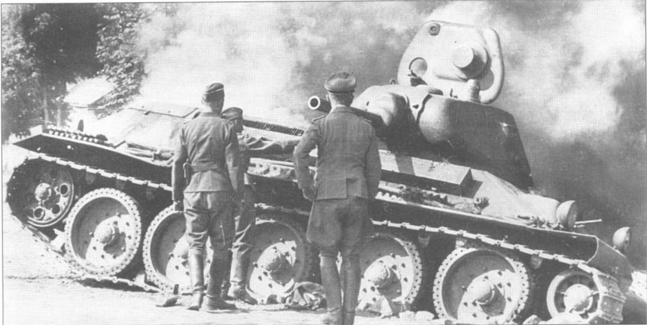
Т-34 образца 1940 г. с литой башней. Сварные башни для танков с пушками Л-11 были более распространенными. Машину осматривают германские офицеры, лето 1941 г.
