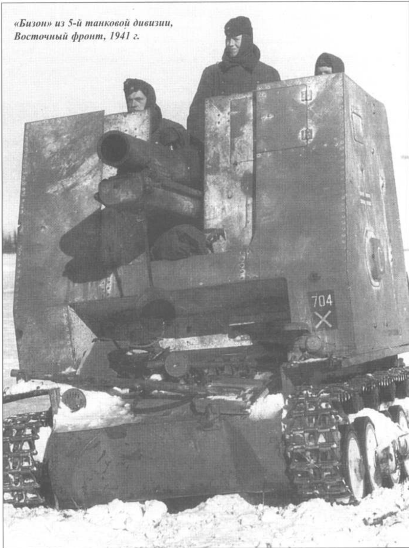
Пушку закатали на шасси Pz. I. Обратите внимание, что орудие оснащено цельнометаллическими колесами без резинового бандаж.
