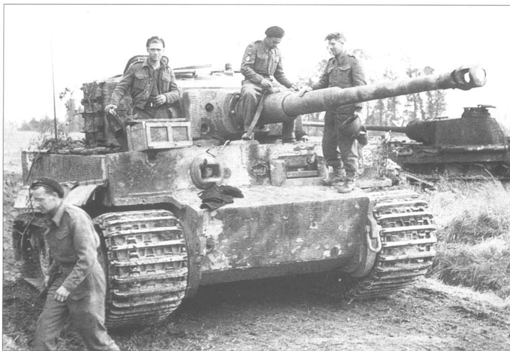
Британские солдаты осматривают брошенный немцами Тигр позднего выпуска, Франция, июнь 1944 г. Снимок хорошо передает внешний вид побывавшего в боях танка: отсутствуют брызговики, юбка помята, циммерит местами отвалился, в броне многочисленные вмятины от снарядов и пуль.
