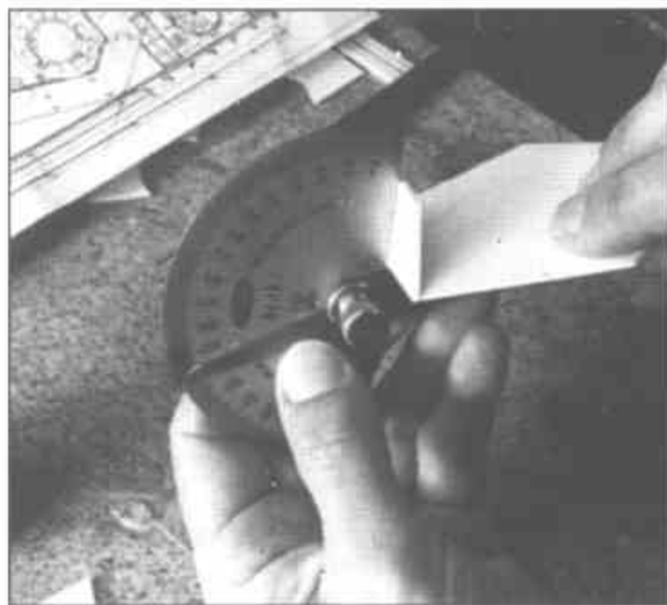
Контроль угла установки листов башни производится металлическим транспортиром.
