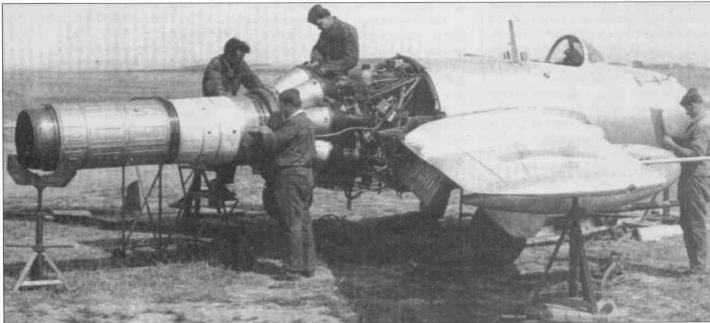
Ремонт двигателя МиГ-15
