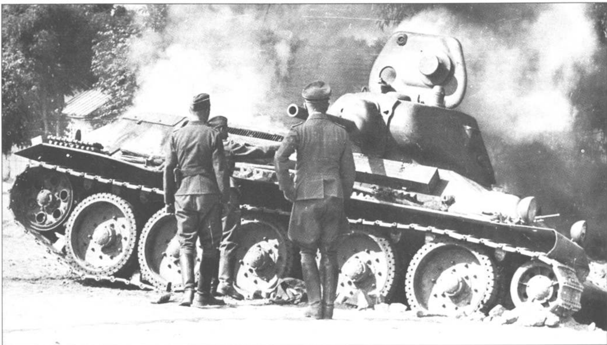
Т-34 обр. 1940 г. с пушкой Л-11 и литой башней. Хорошо видны отличительные особенности танков довоенного выпуска: обрезиненный ленивец, внешние топливные баки на бортах корпуса, смотровой прибор кругового обзора в башенном люке.
