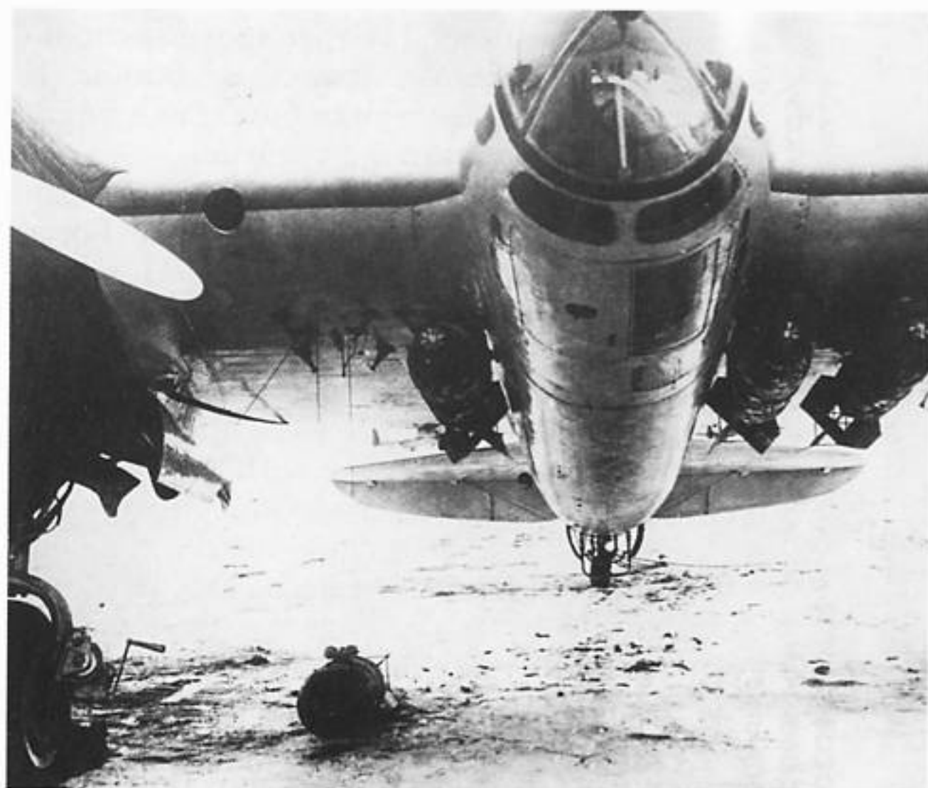
Подвеска ФАБ-250 на держатели НП-1 с помощью закрепленной на стойке шасси ручной лебедки.
