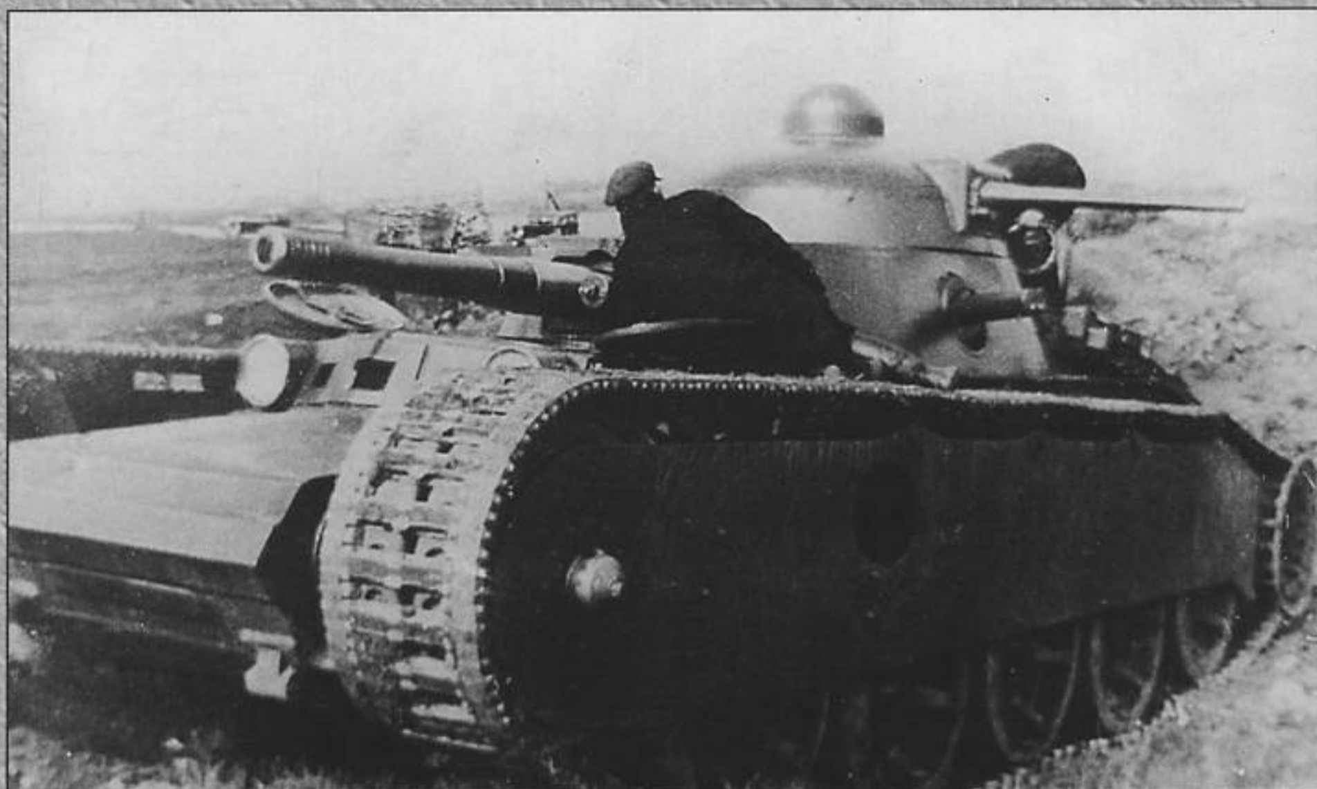
Фотографии на стр. 22-24: Танк Гроте с полностью установленным вооружением в ходе испытаний на проходимость по пересеченной местности на НИИБТ полигоне. 37-мм башенная пушка ПС-1 конструкции П.Н.Сяченко на среднем фото со стороны 24 установлена в положение для зенитной стрельбы.
