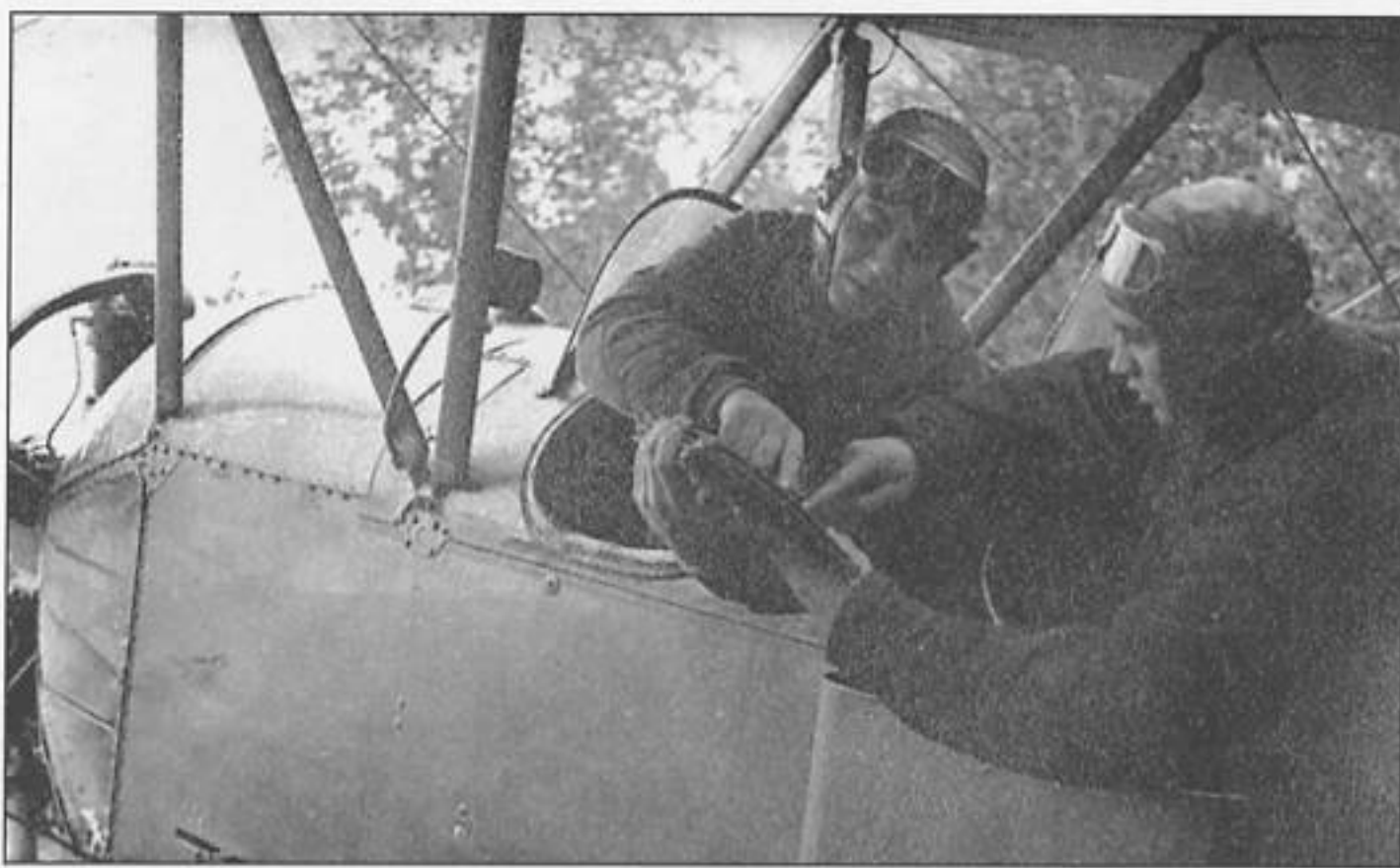
На этой фотографии хорошо виден тахометр, укрепленный на стойке центроплана. Западный фронт, 1942 г.
