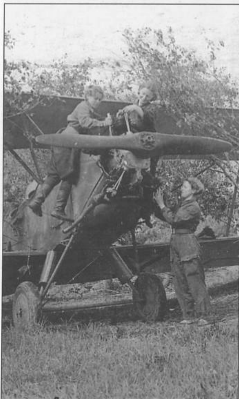
Ремонт мотора У-2 в 46 БАП. Обратите внимание на вырез в правом крыле для работы с бомбовым визиром. Северо-Кавказский фронт, 1943 г.
