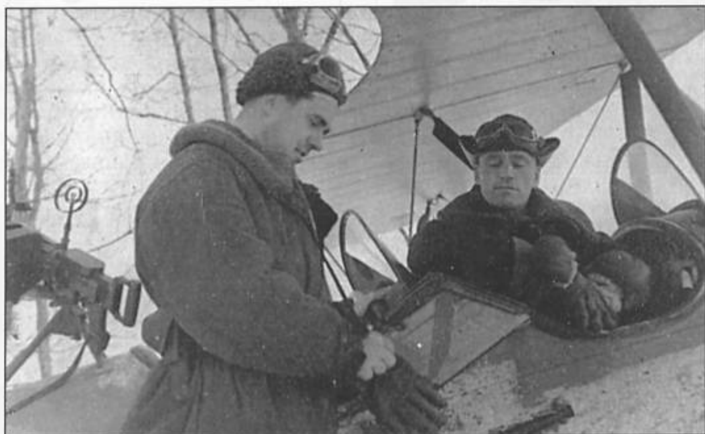
Летчик капитан В.Г.Салов и штурман ст. лейтенант И.П.Радин перед боевым вылетом. Самолет вооружен пулеметом ШКАС с магазинным питанием. 1943 г.
