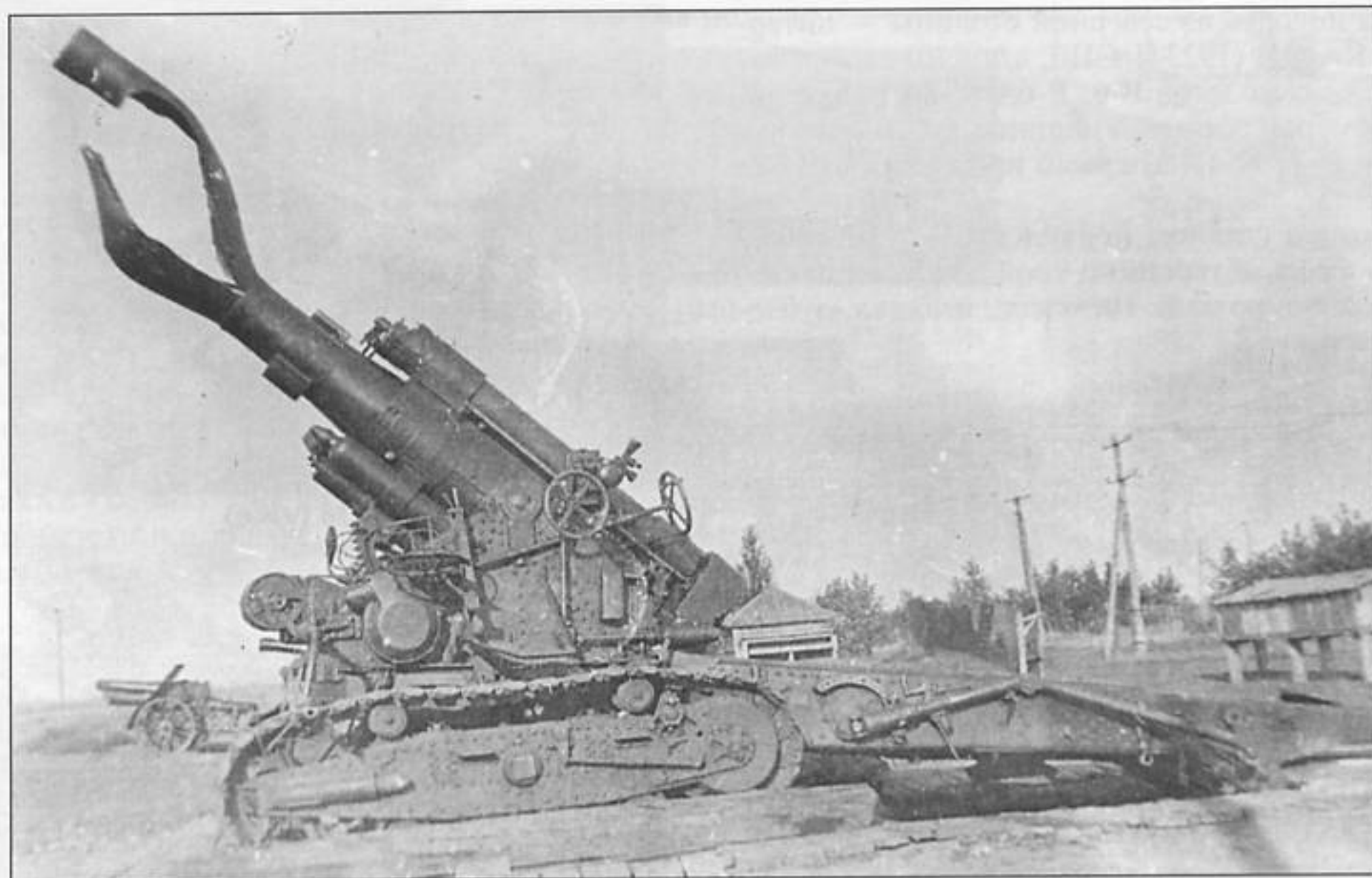
Результат испытаний одного из первых образцов Б-4 полным зарядом. Артполигон, весна 1932 г.
