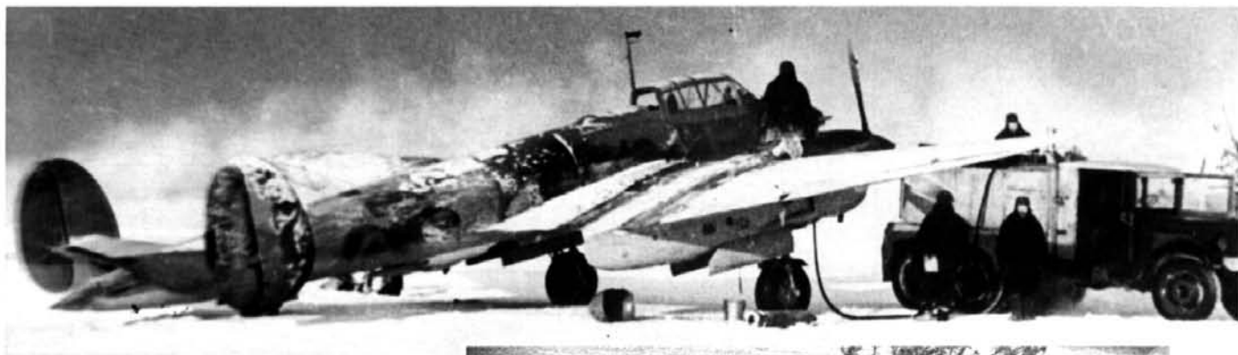
Типичная сценка из аэродромной жизни: VM3-34 заправляет горячей водой Пе-2. Около самолета лежит баллон со сжатым воздухом для аэродромного запуска. (Фото предоставлено М. Масловым)
