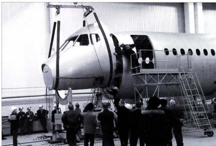
Идет стыковка отсеков фюзеляжа, изготовленных в Новосибирске и в Комсомольске-на-Амуре
