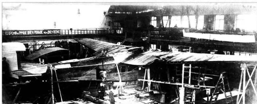
Рис. 9. Сборка самолета АНТ-9 в здании АГОС ЦАГИ, 1929 г.
