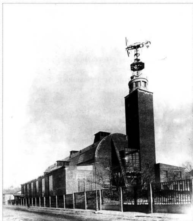
Рис. 4. Здание ЭАО ЦАГИ с аэродинамической трубой Т-I-II, 1925 г.
