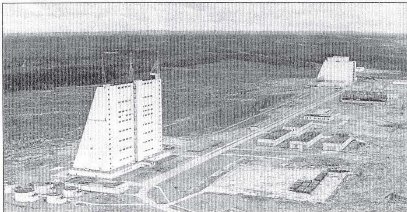
Приемная и передающая антенны РЛС типа "Дарьял" (фото журнала "Военный парад")
