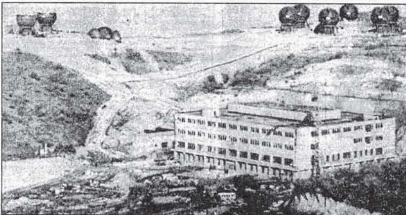
Строительство оптико-электронного комплекса наблюдения за КА в Таджикистане в 80-х годах
