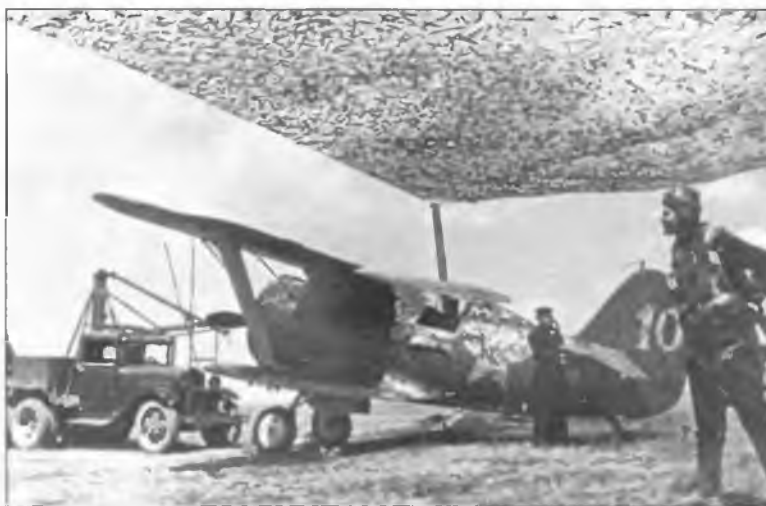
Запуск двигателя И-153 при помощи автостартера
