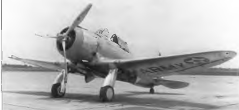
Истребитель Северский P-35 с полуубирающимся шасси
