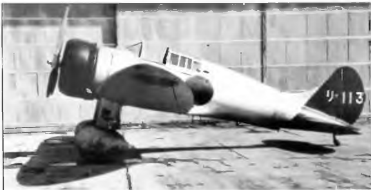
Мицубиси A5M2b (A5M2-Оцу) с полностью закрытой кабиной (фонарь показан в открытом положении) из авиаотряда Хякурикара
