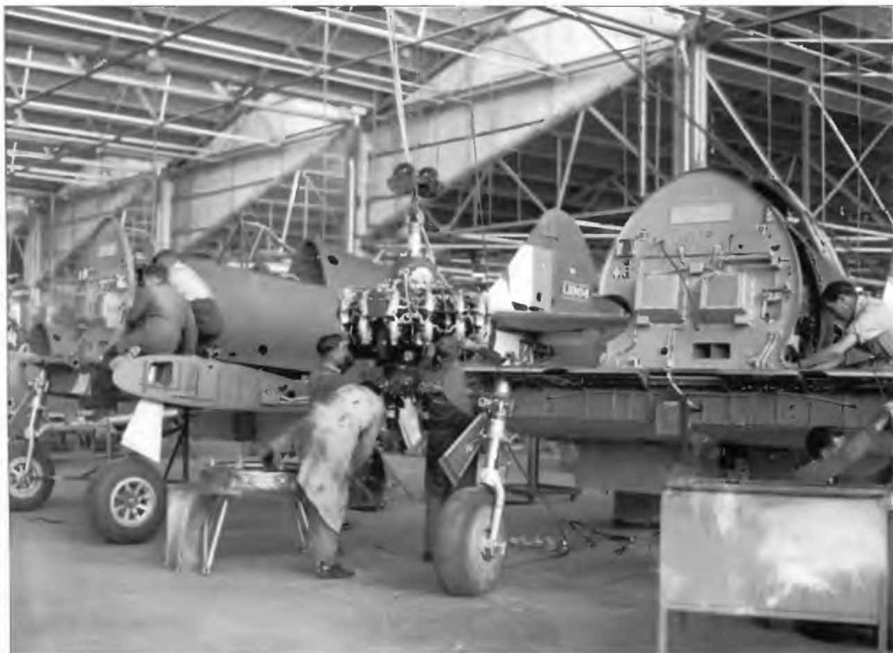
Сборка «Бумерангов» на заводе Фишерменс-Бэнде
