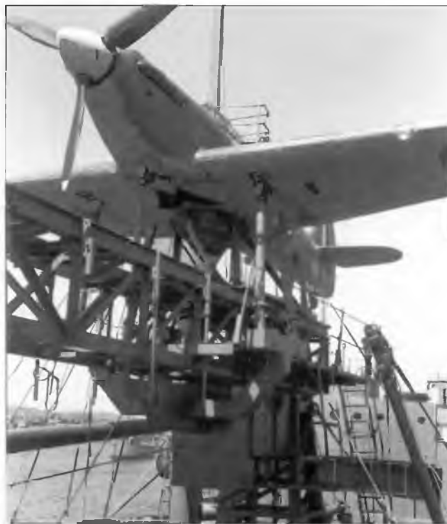
Английский истребитель «Си Харрикейн» Mk.IA, установленный на катапульту
