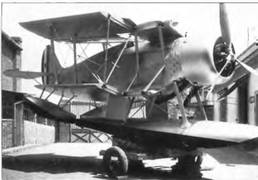
Для обеспечения базирования на кораблях Ro.44 имел складывающуюся бипланную коробку
