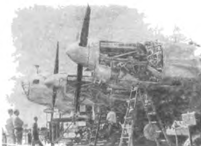
XB-38 - опытный самолет (В-17Е с двигателями Аллисон жидкостного охлаждения)
