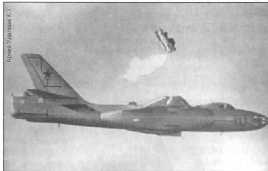
Испытание катапультного кресла Юрием Гарнаевым на ЛЛ ИЛ-28
