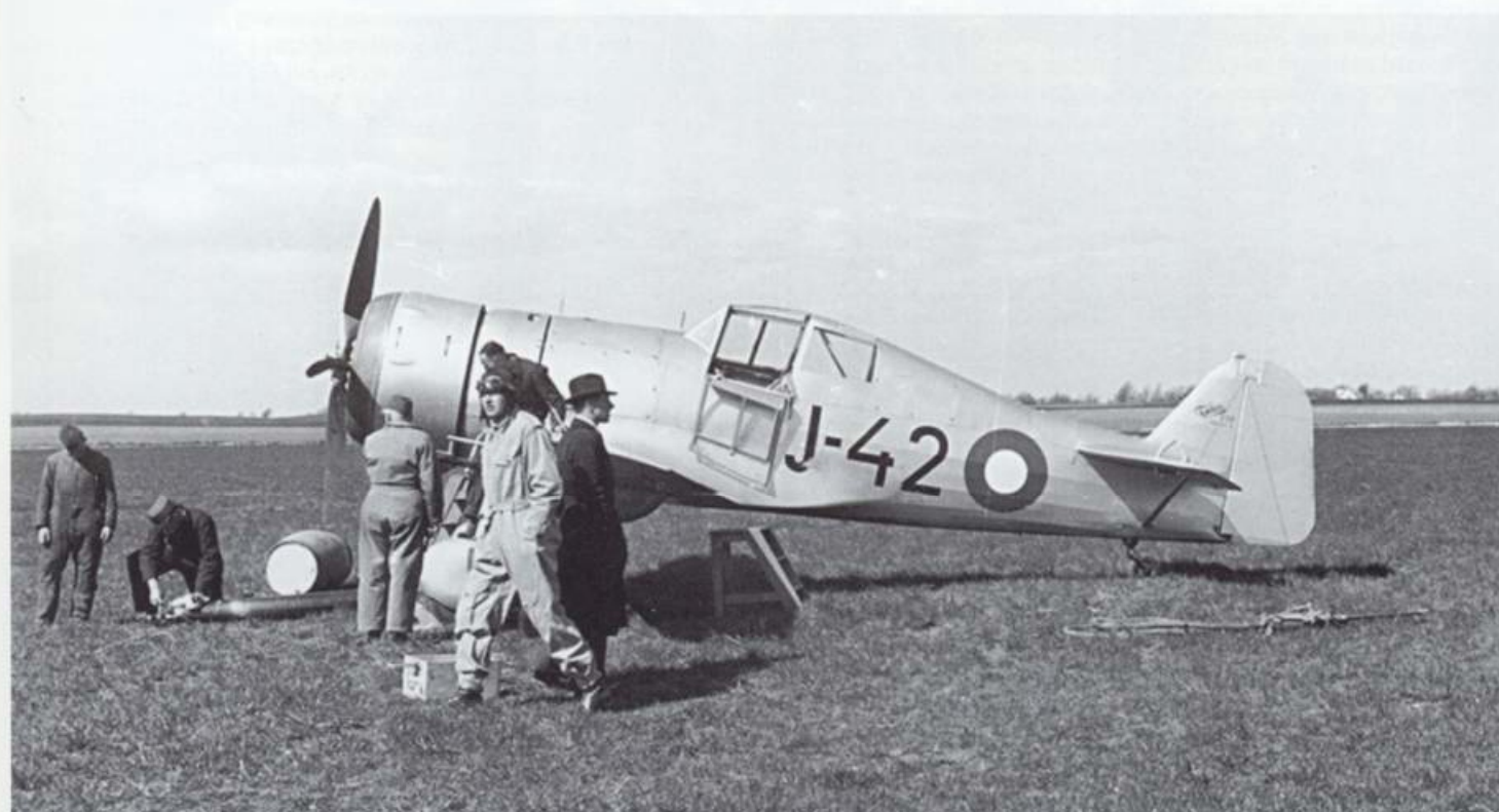
Samolot z oznaczeniem J-42 był jedynym duńskim Fokkerem eksperymentalnie uzbrojonym w dwa 20 mm działka Madsen zainstalowane w gondolach pod skrzydłami. / The J-42 was the only Danish Fokker experimentally armed with two 20 mm Madsen cannons, mounted under the wing.
