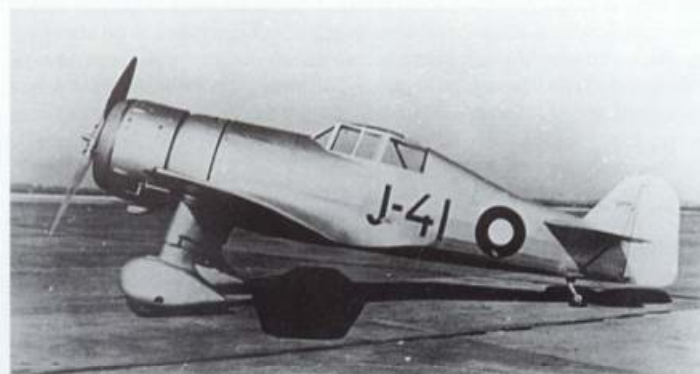
Fokker J-41 - pierwszy samolot w lotnictwie duńskim. Maszyna miała silnik Bristol Mercury VI-S oraz dwułopatowe śmigło Ratier. / The first Fokker (J-41) in Danish aviation. The machine was powered by Bristol Mercury VI-S engine and had two-blade Ratier propeller.
