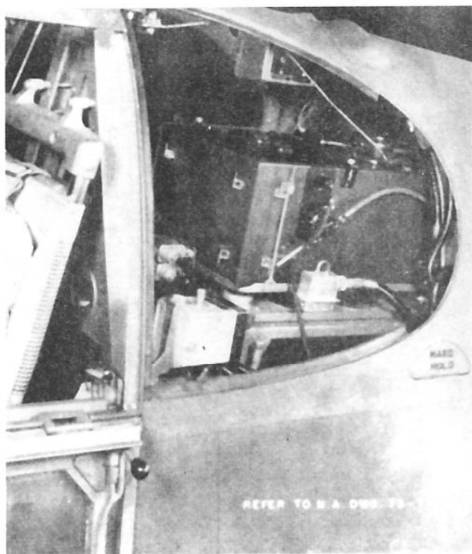
Detale przedziału radiowego za fotelem pilota.
