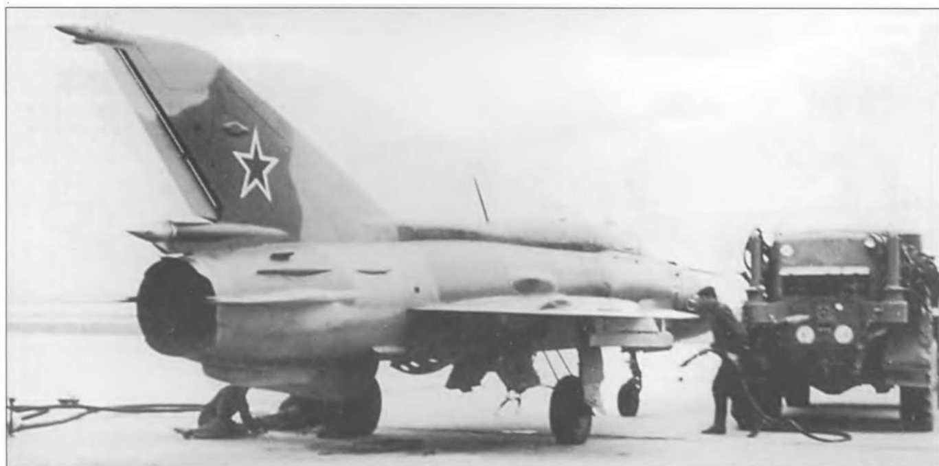
Камуфлированный советский МиГ-21ПФМ («голубой 79») на дозаправке. На этом самолете стоит зеркало заднего вида ТС-27АМШ. С завода самолет был получен неокрашенным, а уже в частях занимались его перекраской, поэтому каждый самолет был уникальным в смысле окраски.
