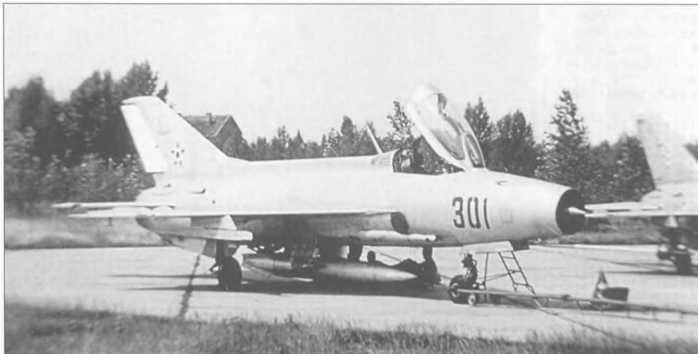
Венгерские ВВС получили свои первые МиГ-21Ф-13 в 1962 году. Первый публичный показ состоялся 4 апреля 1962 года во время авиапарада в Будапеште. Все венгерские самолеты были построены на ГАЗ-30. Этот МиГ («красный 301») с подвешенным топливным баком на 490 литров. Внешний бак был хорошим дополнением к внутреннему баку на 2280 литров на ранних МиГ-21Ф-13 и 2470 - на поздних. Венгры вывели из боевого состава МиГ-21Ф-13 к началу 80-х годов.
