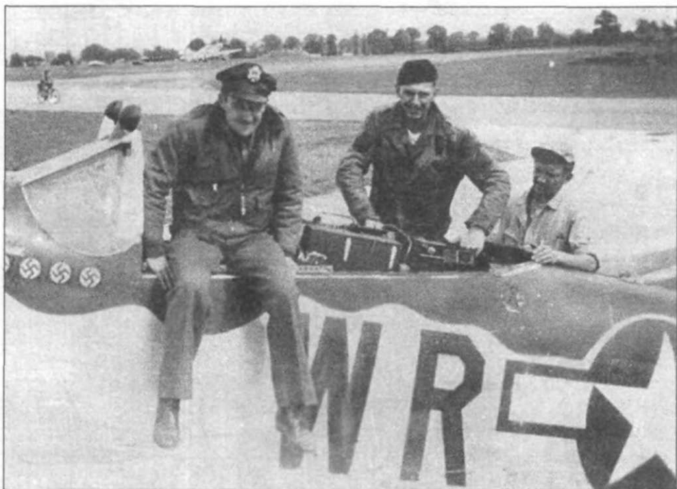
Ли Менденхолл (354-я эскадрилья 355 группы) наблюдает за ремонтными работами на его P-51D Texas Terror IV (№ 44-13571), аэродром Стилл Морден лето 1944 года. Приемник радиопередатчика SCR-695 (и связанный с ним блок SCR-522) существенно влияли на эффективность P-51 как истребителя эскорта. Поэтому, при первом же намеке на неисправность, техникам приходилось снимать подвижную часть фонаря кабины и извлекать весь комплект для ремонта.
