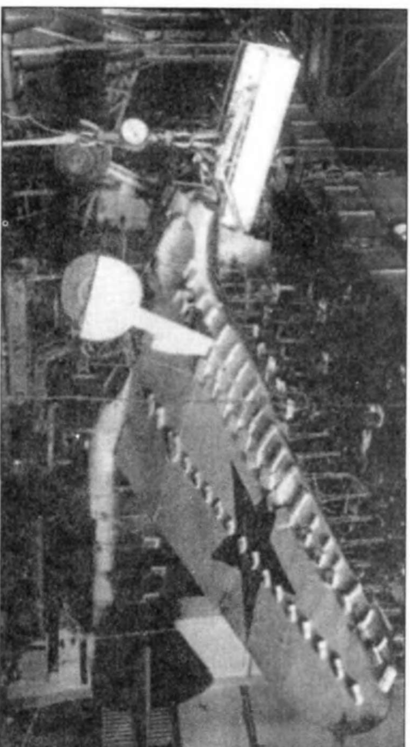
Статические испытания истребителя ЛаИТ-3 в прочностной лаборатории ЦАГИ, конец 1940 г.
