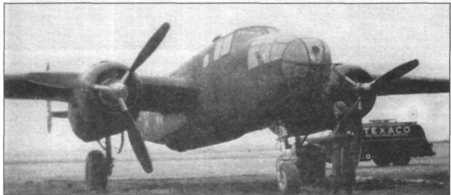
В-25 на базе Эглин-Филд в ходе подготовки к налету. В бомбоотсеке установили дополнительный бензобак, отсутствовавший на стандартном В-25. Вся программа подготовки к налету проводилась в полном секрете, отсюда часовой, стоящий у самолета.
