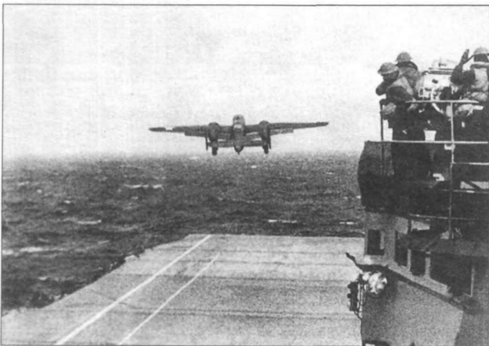
Старт самолета Дулиттла с палубы авианосца «Hornet». Видно, что самолет оторвался от палубы, имея еще солидный запас пробега, и теперь резко набирает высоту.
