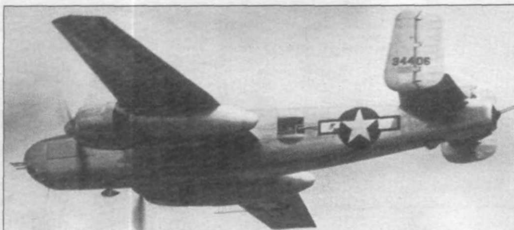
NA-98X в полете. Видны трапецевидные оконцовки крыла и удлиненные элероны.
