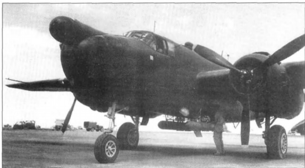
Выкрашенный целиком в черный цвет PBJ-1H из VMB-612. В носовой части установлен радар, под фюзеляжем подвешены ракеты «Tiny Tim».
