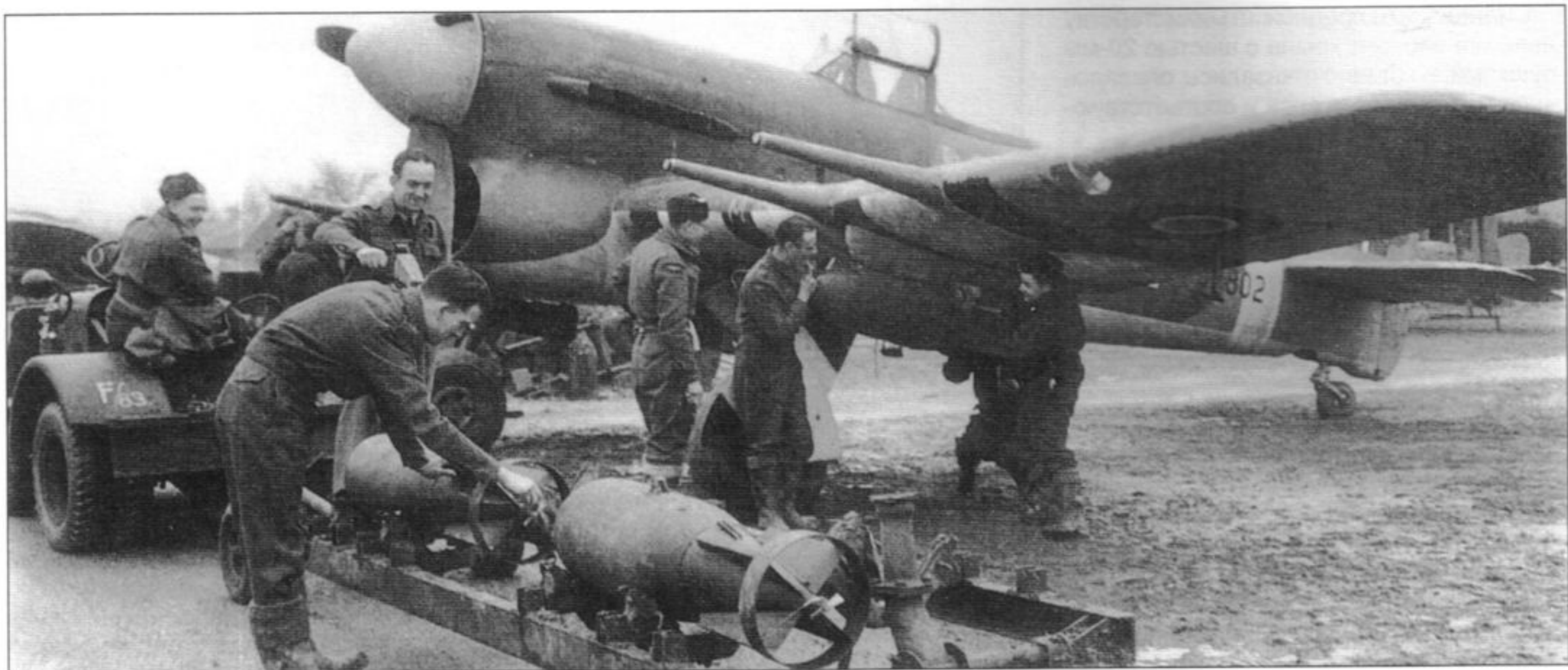
Подвеска бомб под самолёт 245-й эскадрильи на аэродроме Уэстхэмпнетт, начало 1944 г.
