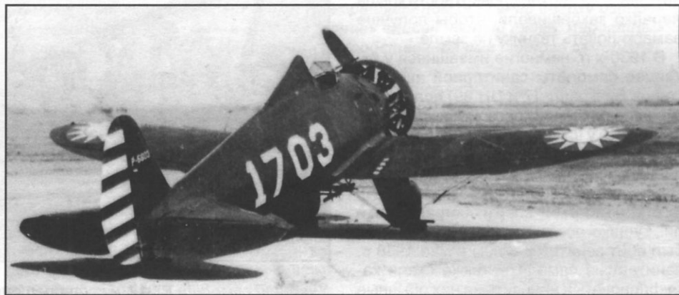
Истребитель Боинг 281 из 17-й эскадрильи с полным комплектом китайских обозначений 1930-х гг.: на крыле – опознавательные знаки, на руле направления – «зебра», на фюзеляже – тактический номер
