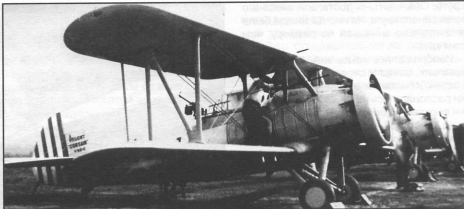
Разведчики V-92C. На киле – обозначение типа машины, «зебра» необычно расположена вертикально
