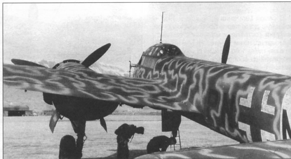
Ju 88A-6/U из LG 1, февраль 1944 г., Авиано (Италия). По исходному камуфляжу цветов RLM 70/71 нанесены распылителем светлые волны (RLM 76, 65 или 02)
