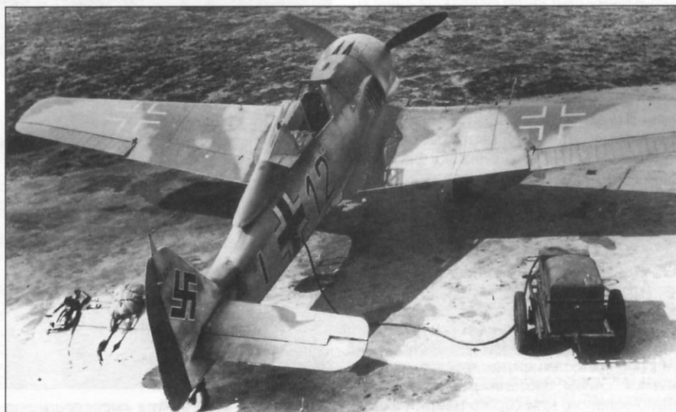
Новенькие истребители Bf 109G-1 на заводском аэродроме. На самолеты нанесены знаки четырехбуквенного кода, которые будут закрашены после прибытия в часть. Окраска машин — комбинацией цветов RLM 74/75/76 с пятнами RLM 02 на бортах фюзеляжа
