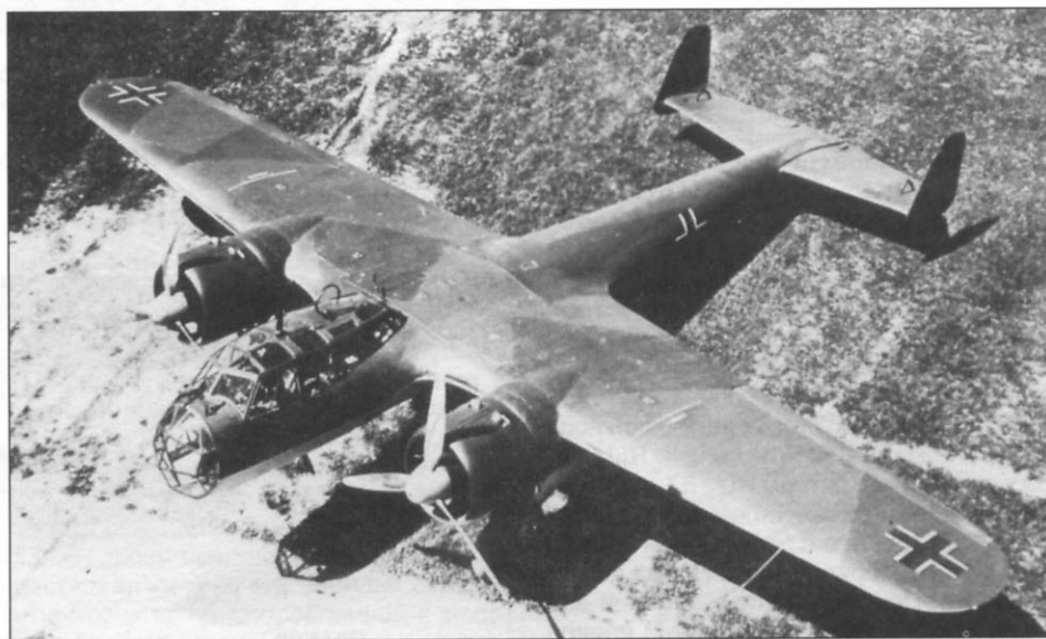
Do 17Z в трехцветном (RLM 70/71/65) камуфляже. Хорошо видно расположение цветовых полей на крыле
