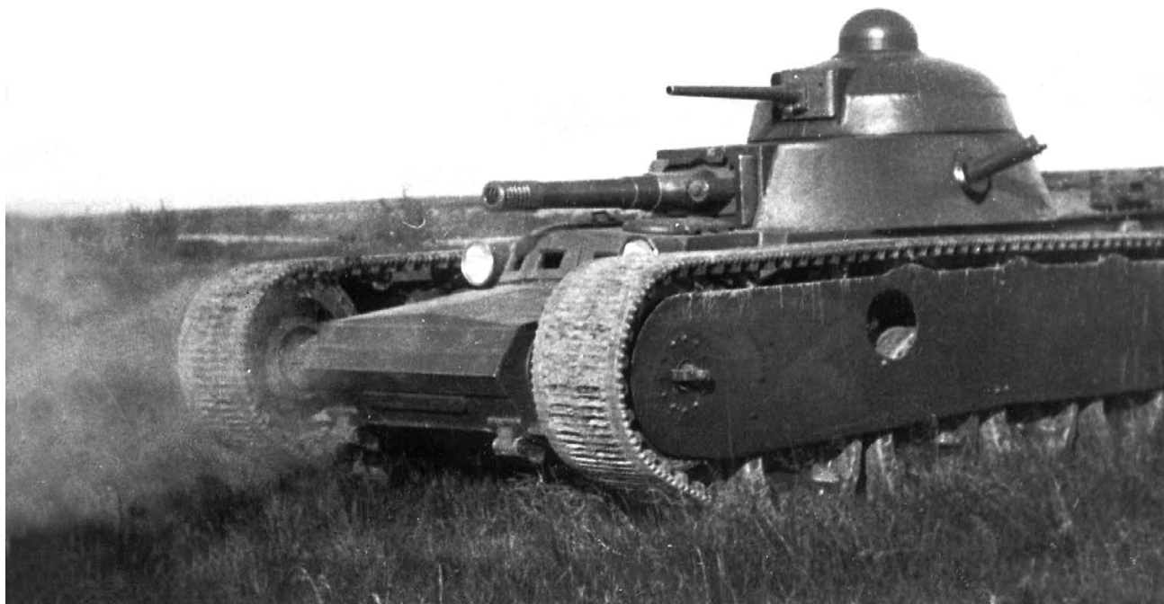
Танк Гроте на испытаниях. Лето 1932 года. На фото – стрельба из 76-мм пушки с хода (АСКМ).
