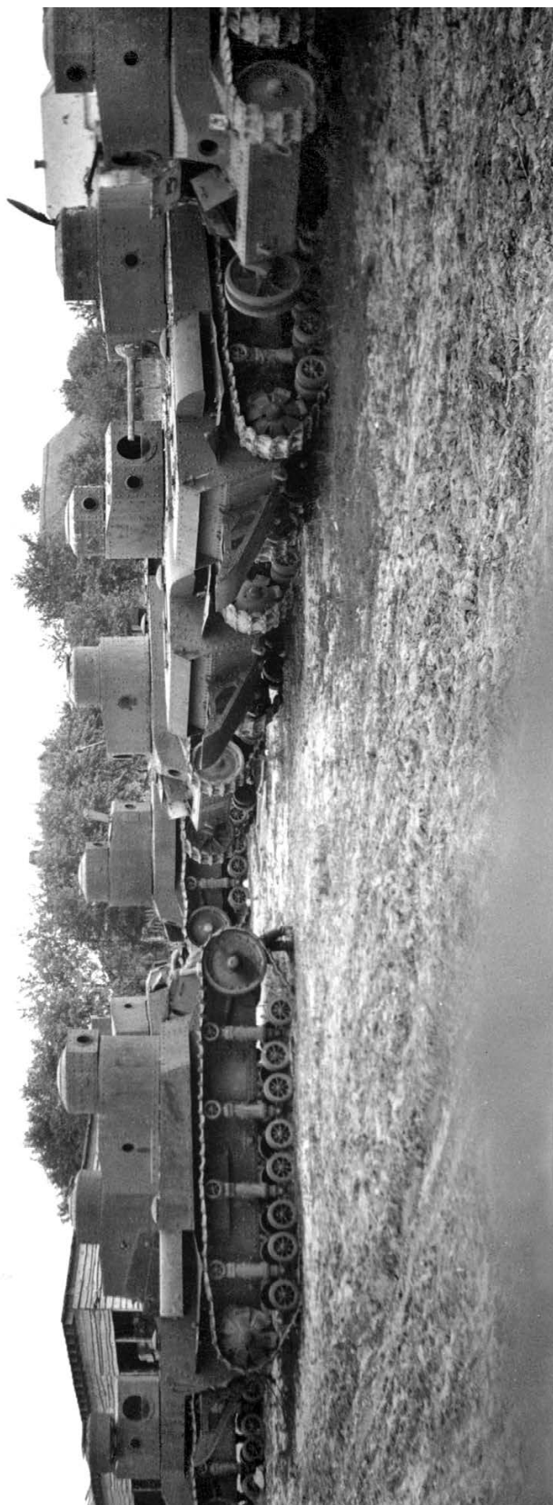
На этом фото видны не менее девяти танков Т-24, предназначенных для установки в качестве огневых точек. Фото сделано на Украине летом 1941 года. Обратите внимание, что одна машина имеет штатно установленную 45-мм пушку обр. 1930 года (АСКМ).
