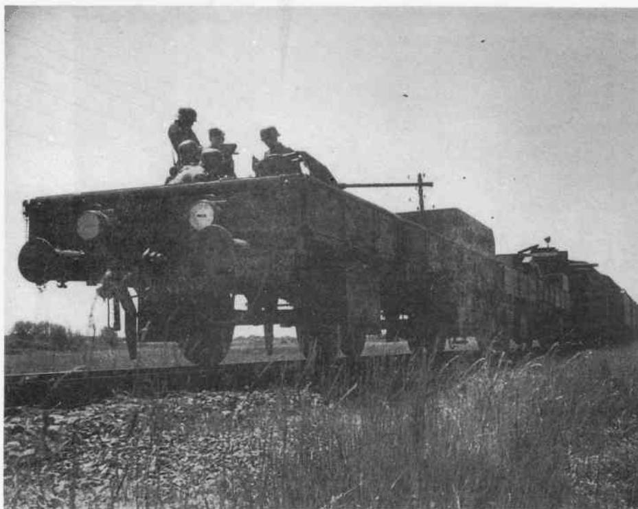
На передней платформе бронепоезда номер 22 располагалось 2-см зенитное орудие. Платформа по периметру имела защиту из невысоких бронестенок.
