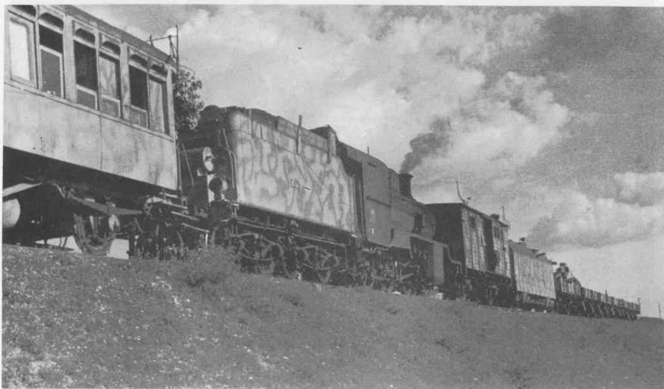
Необычный "защищенный поезд", сфотографированный где-то на юге Франции в начальный период войны. Исключительным является факт эксплуатации пассажирского вагона в составе данного бронепоезда. Обратите внимание, что к французскому локомотиву серии 1С прицеплен немецкий тендер от паровоза серии G10.
