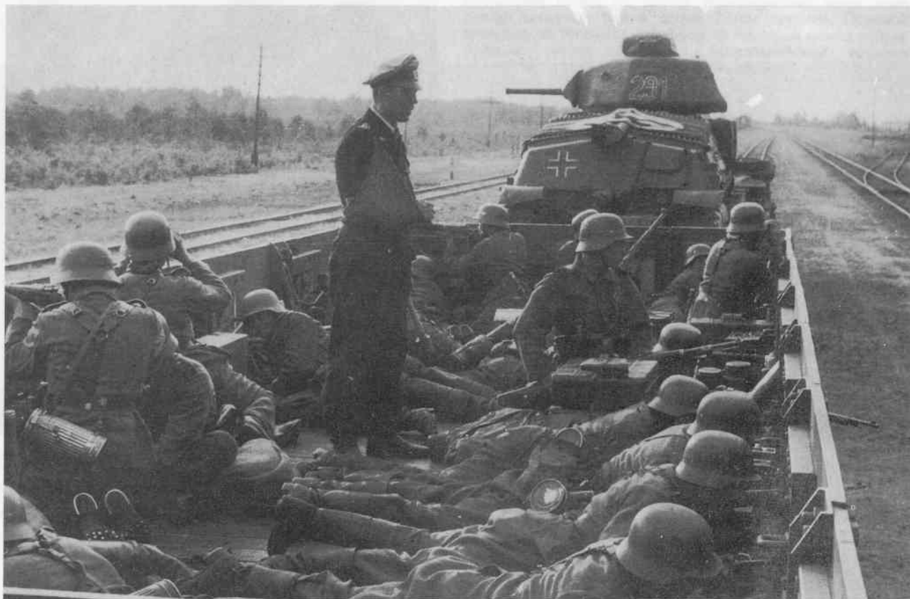
Платформа, где размещалась пехота, имела по своему периметру бронестенки с бойницами для стрельбы из стрелкового оружия.
