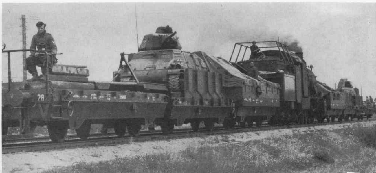
Полный вид бронепоезда номер 28. Артиллерийские вагоны, не имеющие крыши, покрыты брезентом на случай дождя. Паровоз имеет защиту только кабины локомотивной бригады. Тендер и остальная часть локомотива оставались незащищенными.
