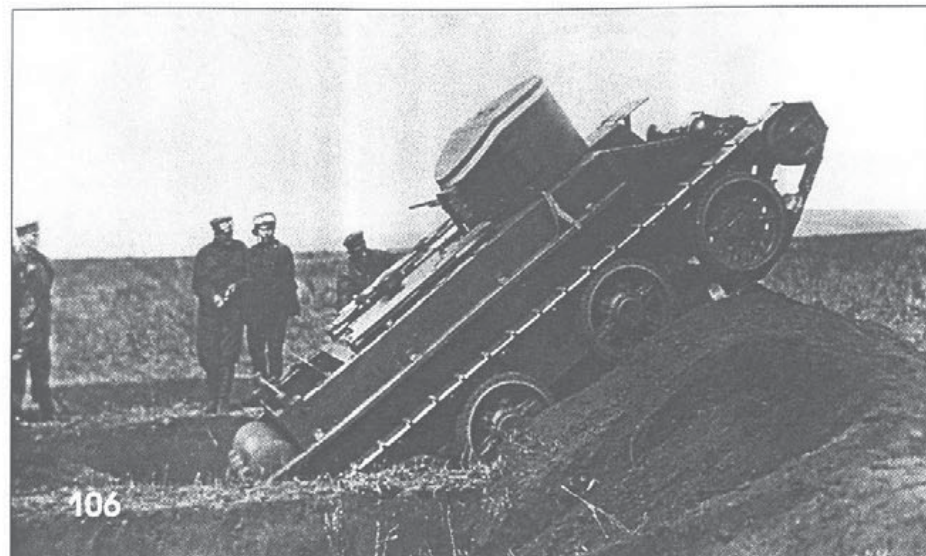
105. БТ-2 преодолевает деревянные надолбы. The BT-2 crosses the anti-tank obstacles.
