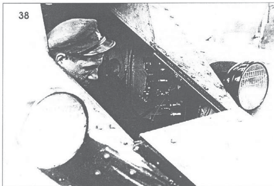
38. Установка щитка контрольно-измерительных приборов. The instrument panel.
