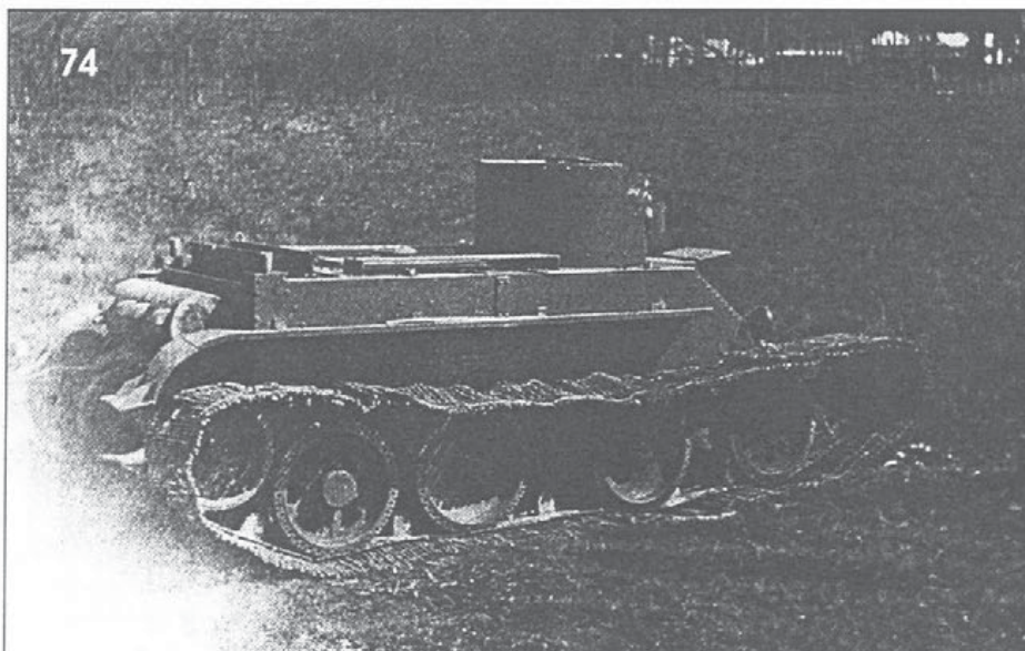
74. БТ-2 с установленной деревянной болотоходной гусеницей во время движения по заболоченному участку. The BT-2 with the... crossing wooden track on the run.
