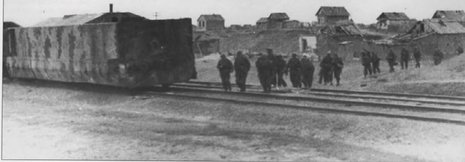
41. Головная бронеплощадка бепо, изображенно-го на фото 40. Видно, что стрельба из орудия была возможна только вперед по ходу состава (АСКМ).
