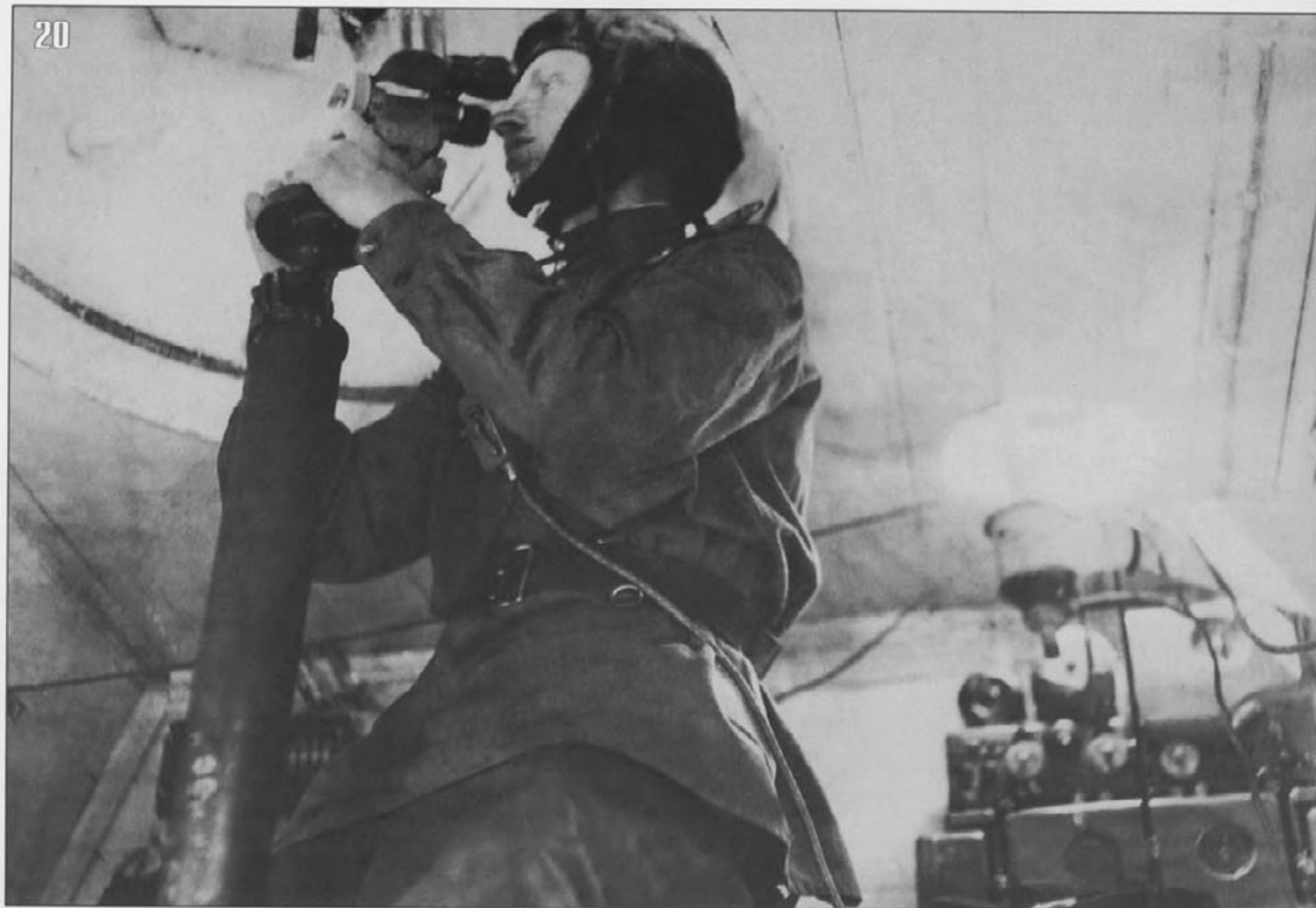
20. В командирской рубке бронепаровоза ПР-43. 1-й отдельный учебный полк бронепоездов, лето 1943 года. Командир ведет наблюдение через стереотрубу, на заднем плане видны блоки радиостанции и телефона (АСКМ).
