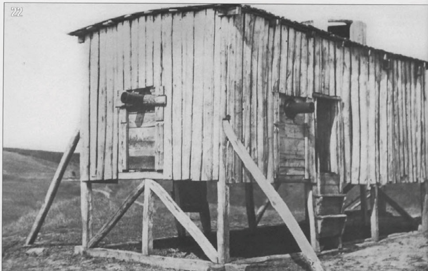
22, 23. Учебные пособия 1-го отдельного учебного полка бронепоездов: деревянные «бронеплощадки» для обучения артиллеристов и пулеметчиков. Лето 1943 года. Хорошо видны установленные в бортах бронировки пулеметов Максима (АСКМ).
