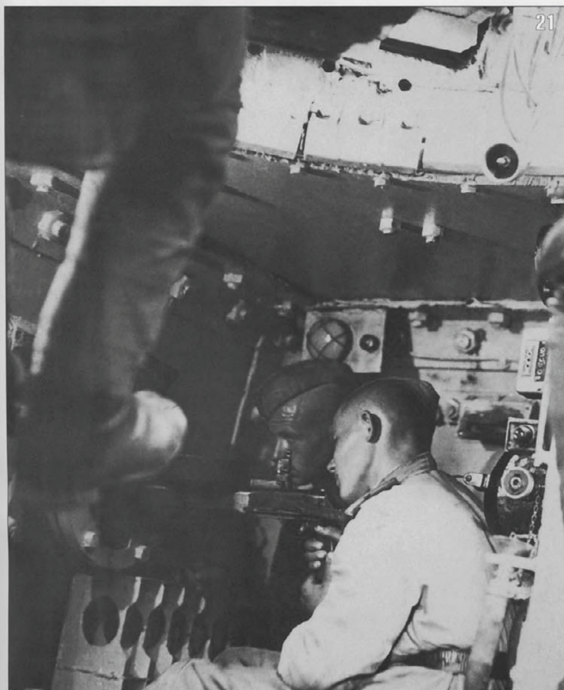
21. Занятие в легкой бронеплощадке ПЛ-43: хорошо виден расчет пулемета ДТ, стеллажи для укладки пулеметных дисков, плафон электрического освещения. 1-й отдельный учебный полк бронепоездов, лето 1943 года (АСКМ).
