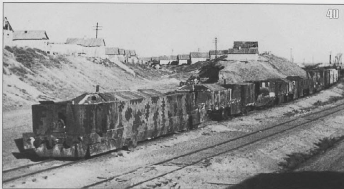
40. Один из инициативных бронепоездов постройки осени 1941 года, захваченный немцами. Предположительно лето 1942 года. Состав не имеет башен, при его изготовлении частично использовались металлические угольные полувагоны. Обращает на себя внимание оригинальный пятнистый камуфляж (АСКМ).
