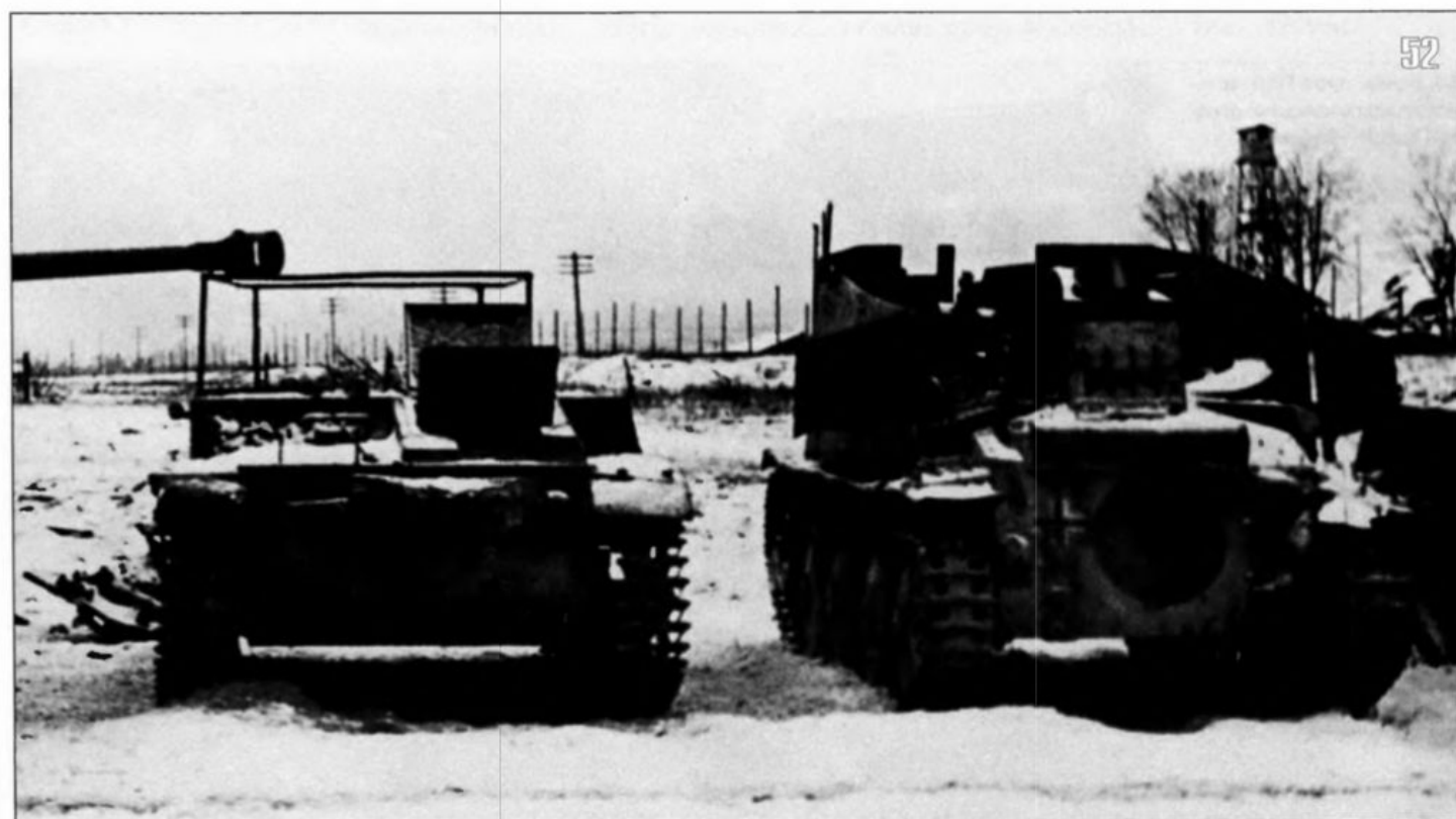
51, 52. Инженерный танк на шасси Pz.II Ausf.A-C, захваченный частями Белорусского фронта в декабре 1943 года. Хорошо видны металлические дуги для установки брезентовой «кабины».
