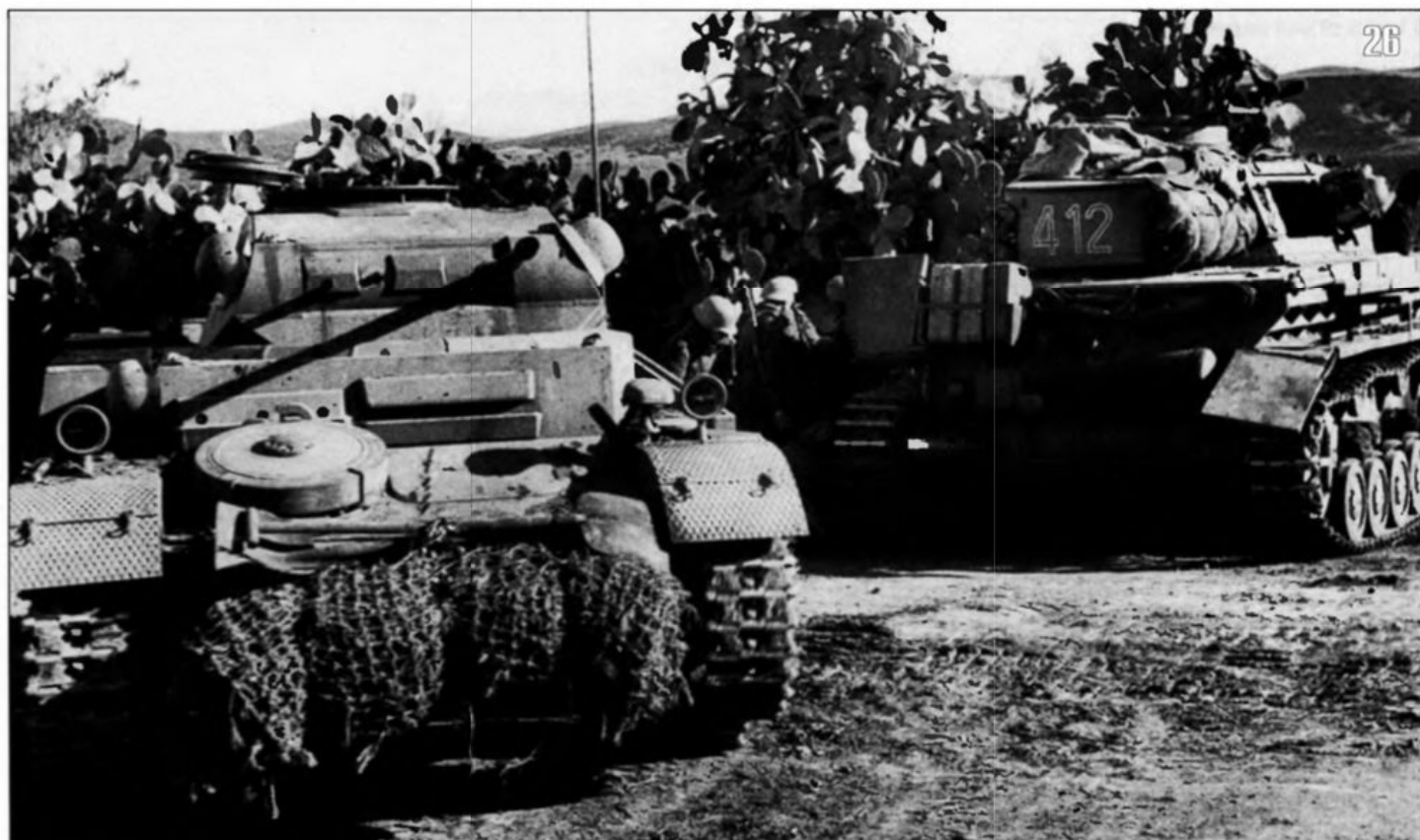
26. Легкий танк Pz.II Ausf.F из состава 21-й танковой дивизии вермахта, вид спереди. Северная Африка, март 1943 года. Хорошо видно запасной опорный каток на верхнем переднем листе корпуса, а также маскировочные сети, закрепленные на переднем листе корпуса.
