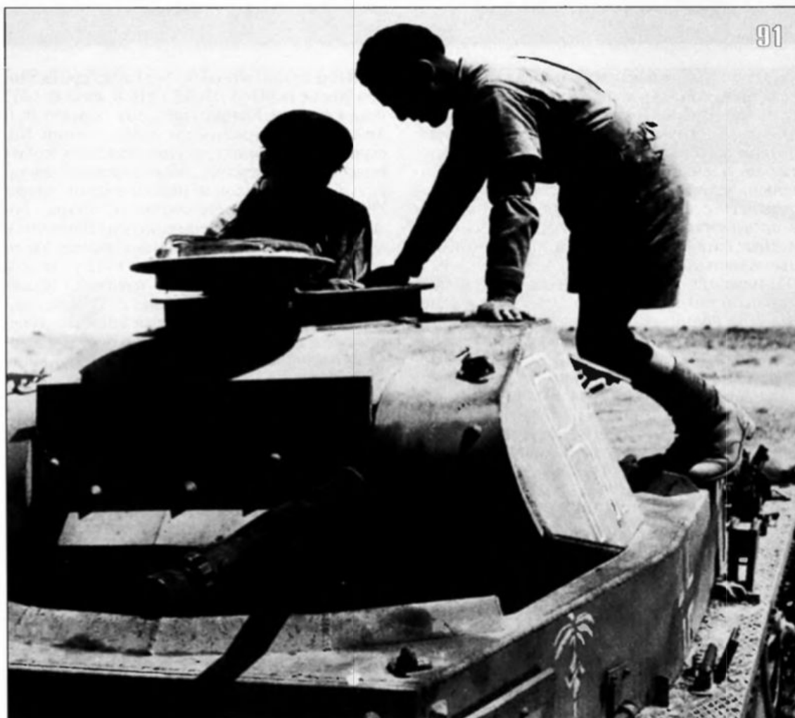
91. Британские солдаты осматривают трофейный немецкий танк Pz.II Ausf.A-C. Северная Африка, апрель 1941 года. Хорошо видна дополнительная бронировка передней части башни.
