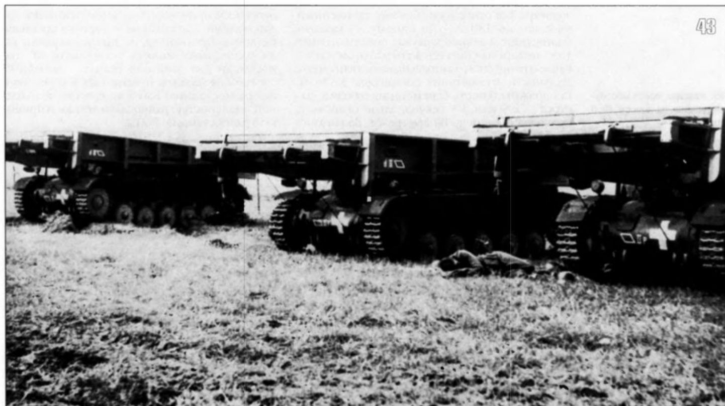
43. Мостовкладчики на шасси танков Pz.II Ausf.A или B. Судя по большим белым крестам, эти машины использовались в ходе Польской кампании.
