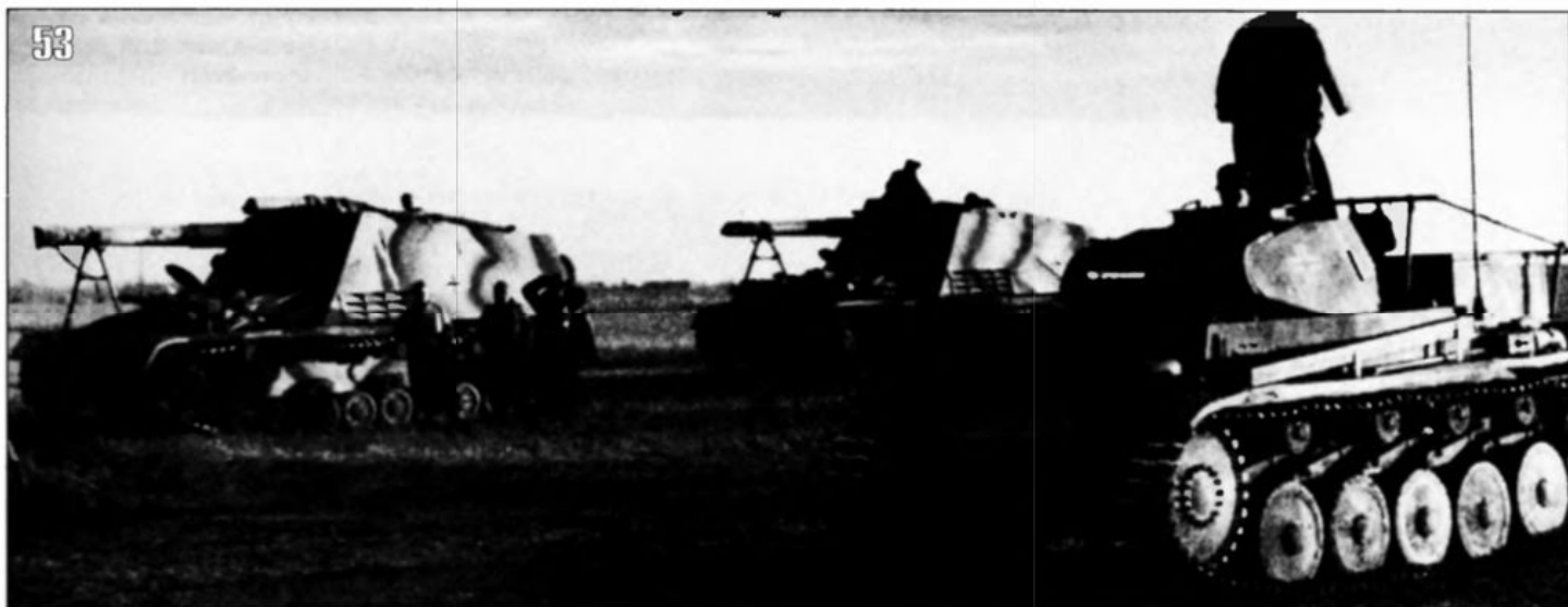
53. Машина передовых артиллерийских наблюдателей (Panzerbeobachtungswagen) на шасси танка Pz.II. 20-я танковая дивизия вермахта, лето 1944 года.
