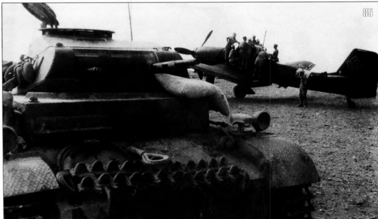
85. Танк Pz.II Ausf.F из состава одной из дивизий немецкого Африканского корпуса. 1942 год. На верхнем переднем листе корпуса уложены запасные траки, за танком виден пикирующий бомбардировщик Ju-87.
