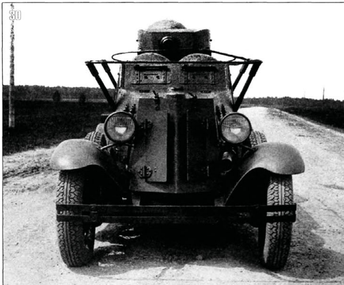
30. Броневедомитель ГАЗ-ТК, вид спереди. НИИТ полигон, июнь 1935 года. Хорошо видна поручневая антенна и ограничитель углов склонения пулемета (АСКМ).
