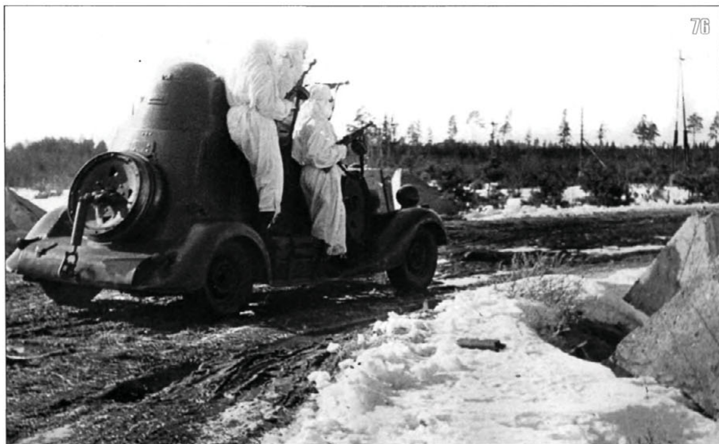
75, 76. Бронеавтомобиль БА-20-жд (на базе БА-20М) — на фото 75 установка броневика на рельсы для замены колес, на фото 76 разведчики отправляются на рекогносцировку пути. Железнодорожные бандажи закреплены на корме и бортах корпуса (АСКМ).
