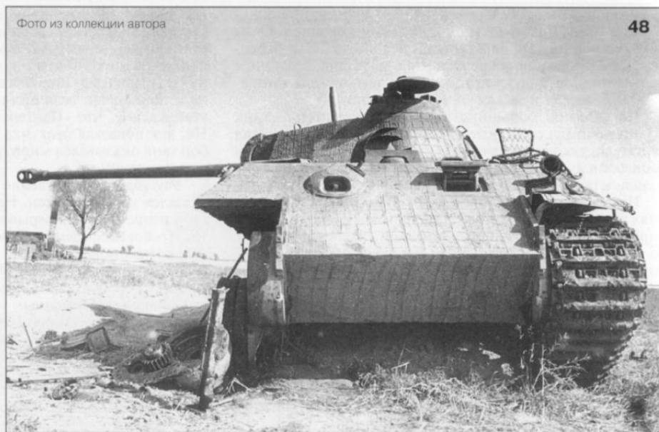
48 «Пантера» Ausf A, подорвавшаяся на mine. Украина, 1944 г. The PzKpfw V Ausf A destroyed by anti-tank mine. Ukraine, 1944.
