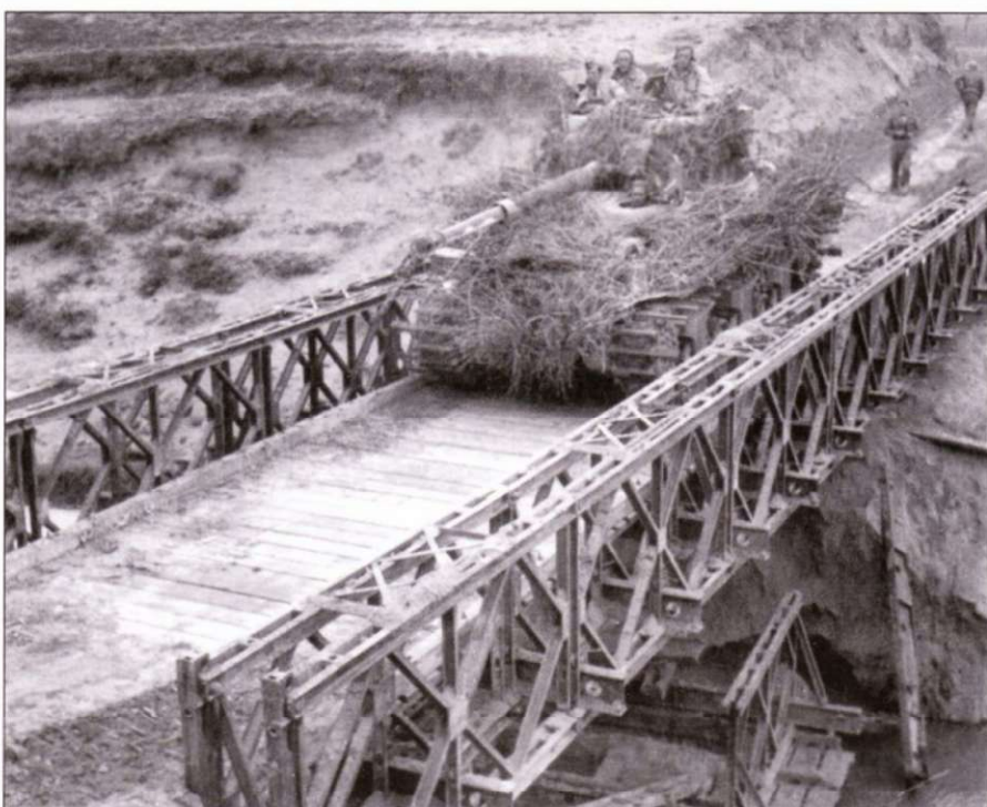
Не взирая на экстремальный камуфляж, данный танк идентифицирован как «Шерман Гибрид ПС» - вооруженный 17-фунтовой пушкой вариант «Шермана Гибрида IC». Танки с 17-фунтовыми пушками союзники очень широко применяли в сражениях на территории Западной Европы, но крайне редко в Италии. На траки гусениц «Шермана» установлены уширители. Снимок выполнен на мосту через Сантерно у города Имола 12 апреля 1945 г.
