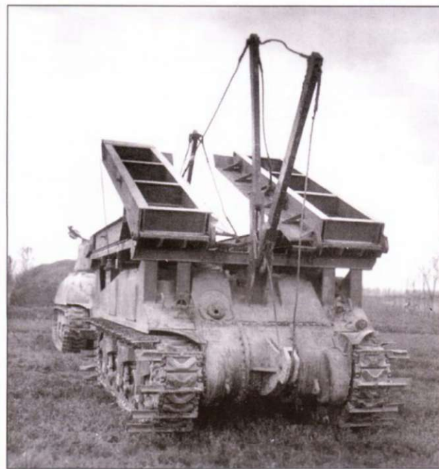
«Шерман Тваби» - мостовкладчик на шасси «Шермана V». Четыре таких мостовкладчика изготовили на базе линейных танков весной 1945 г. На заднем плане - «Шерман ПА», снимок сделан 4 апреля 1945 г. Обратите внимание на уширители «Платипас», смонтированные на гусеничных траках Т48. Уширители были популярны у танкистов, поскольку серьезно улучшали проходимость «Шерманов», однако их монтаж или демонтаж занимал 8 часов.
